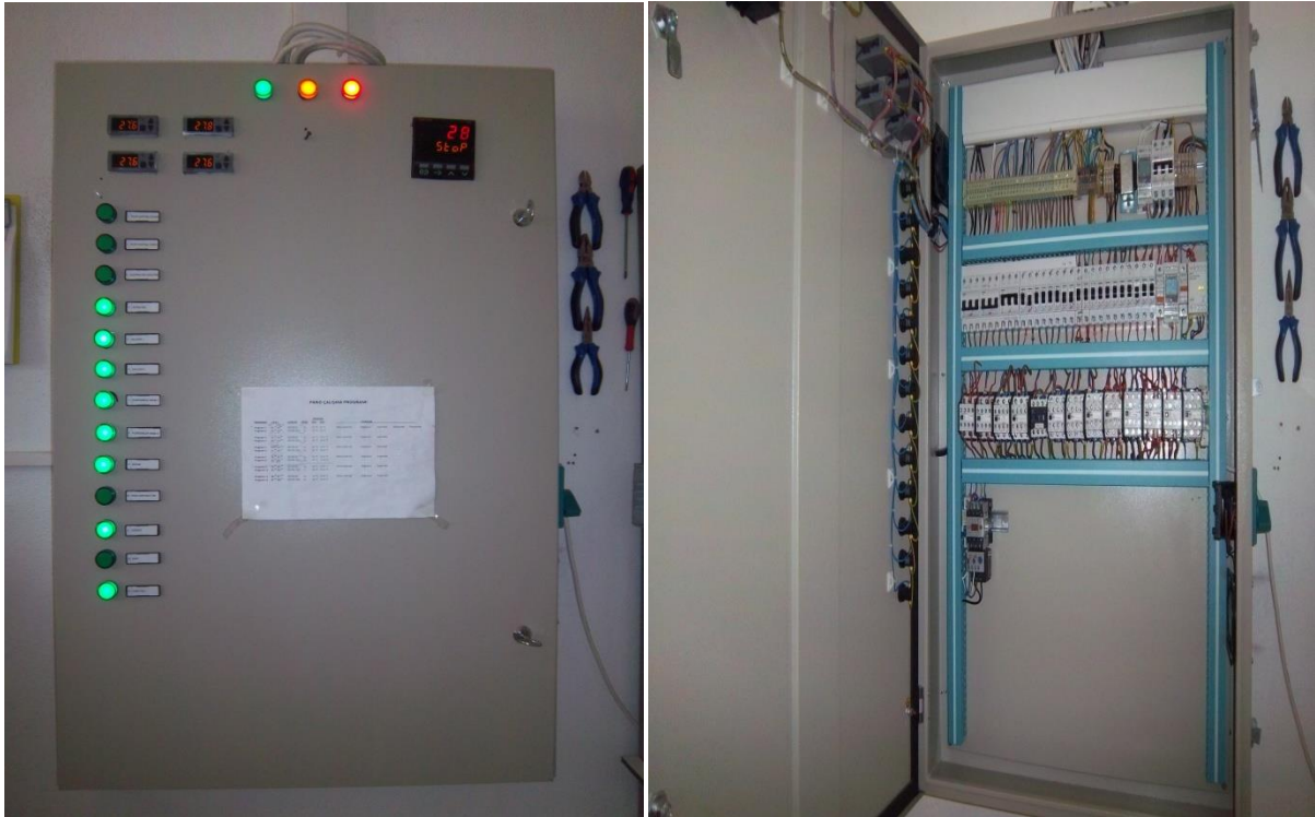
Şekil 3.1. İklim odası otomatik kontrol panosunun dıştan ve içten görünümü
