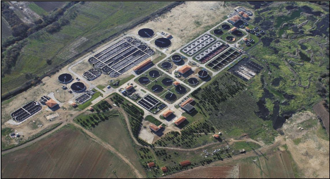
Şekil 5.1. Arıtma tesisinin üstten görünüşü
