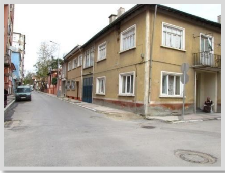
Şekil 4.46. Bakımsız yapı örneği
