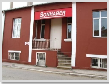
Şekil 4.54. Bakım-onarımı yapılmış tarihi yapı
