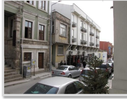
Şekil 4.8. Cadde içerisindeki eski ve yeni yapılar
