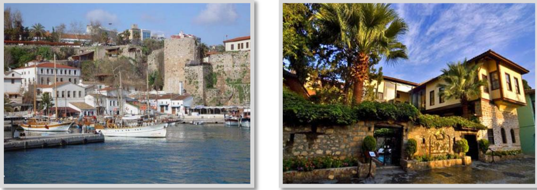
Şekil 2.13. Kaleiçi liman bölgesinden genel görünüm (İnt. 11).
