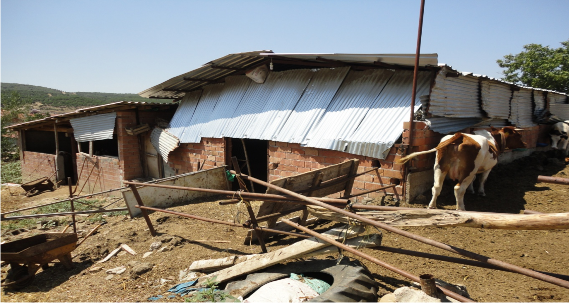
Şekil 4.5. Projersiz planlanmış bir barınağın yapısal durumu
