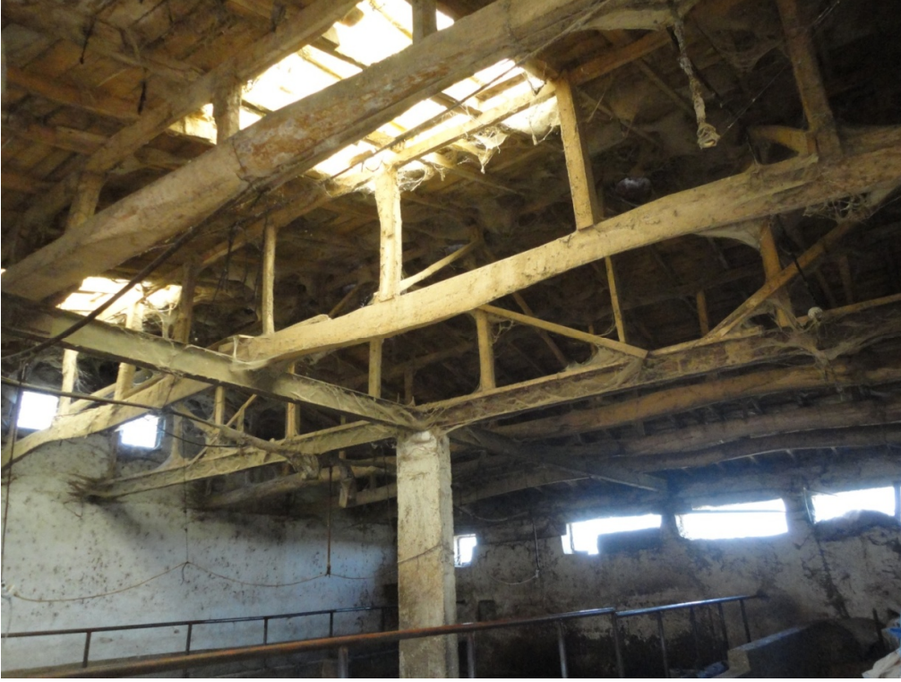
Şekil 4.34. Çatı iskelet malzemesi ahşap olan ahır
