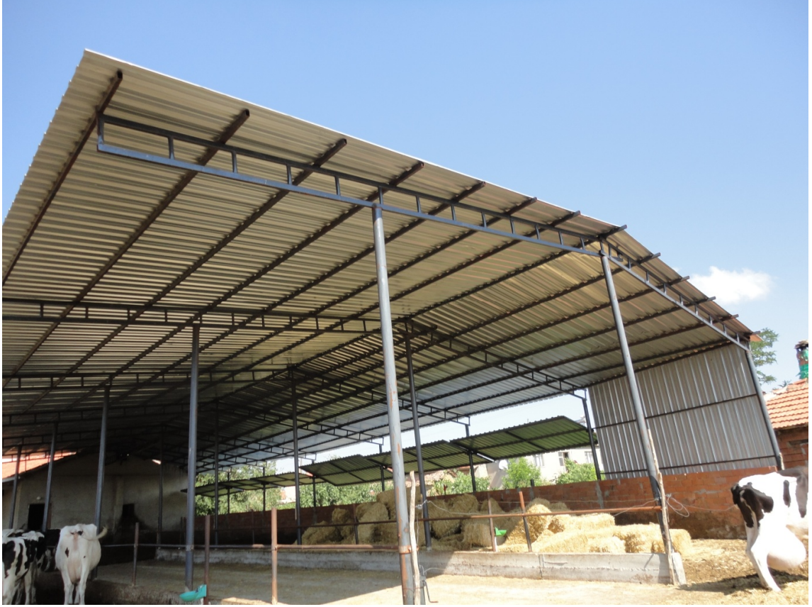
Şekil 4.33. Tuğla-sac duvar örneği
