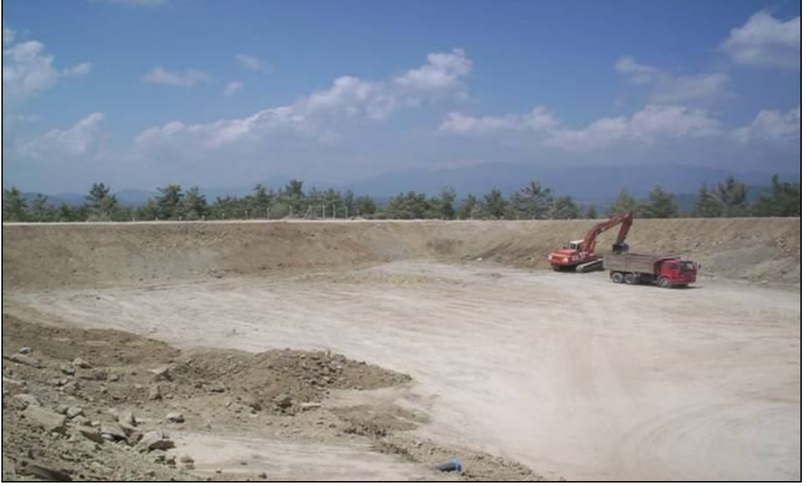
Şekil 2.10. Düzenli depolama tesisinde tesviye işlemi. (Anonim 2009 c)
