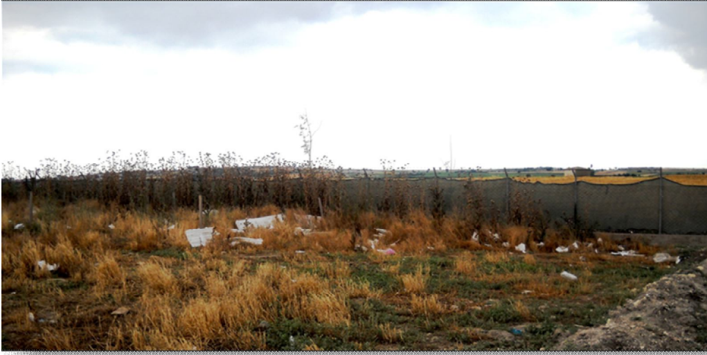
Şekil 5.5. Katı atık alanının etrafına takılan rüzgar perdeleri
