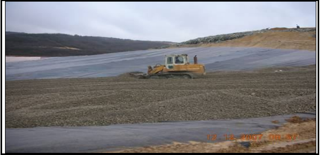
Şekil 2.16. Sızıntı suyu drenaj sisteminin üzerine çakıl döşenmesi (Anonim 2009 c)
