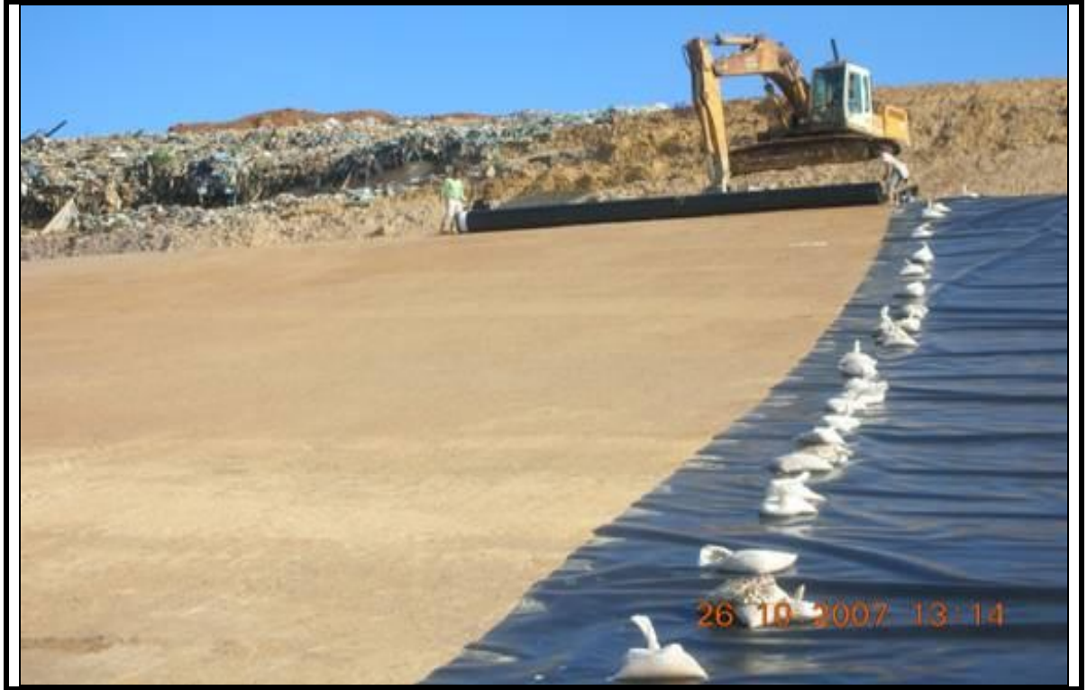
Şekil 2.11. Düzenli depolama sahalarında HDPE geomembran tabakası serilmesi. (Anonim 2009 c)
