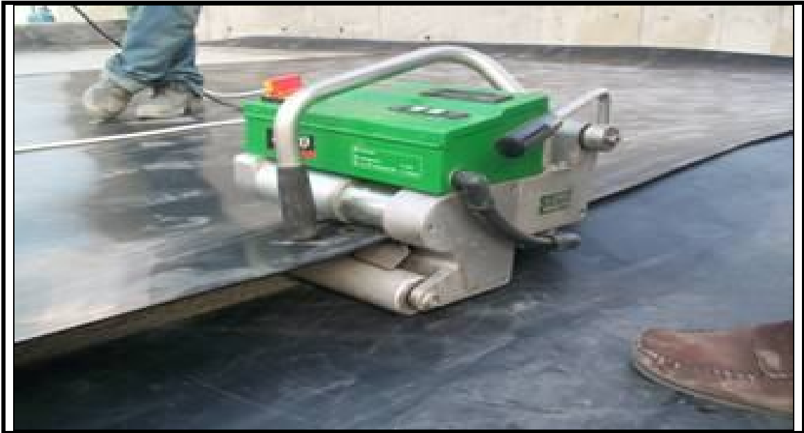
Şekil 2.13. HDPE geomembran örtüye kaynak yapılarak tek parça haline getirilmesi işlemi (Anonim 2009 c).
