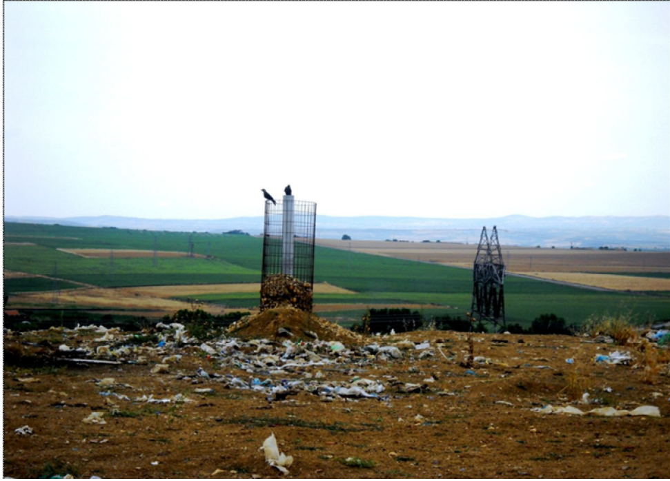
Şekil 5.4a Katı atık alanındaki gaz toplama bacası (Özgün)
