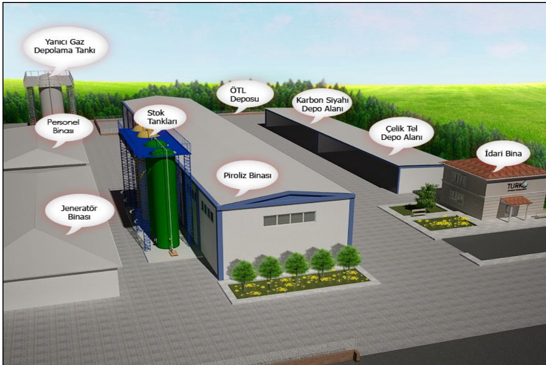
Şekil 2.27. Piroliz tesisi genel görünüm (Anonim 2010g)
