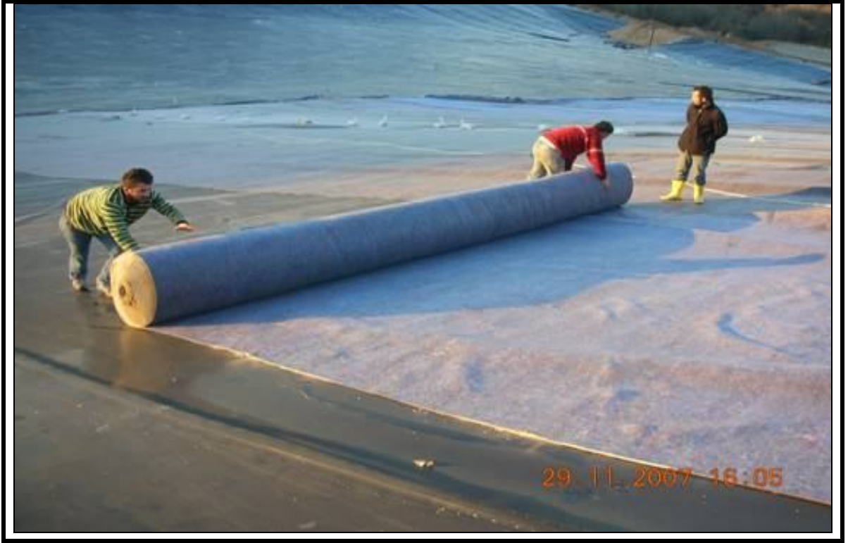
Şekil 2.14.Koruyucu geotekstil örtü serilmesi (Anonim 2009 c)
