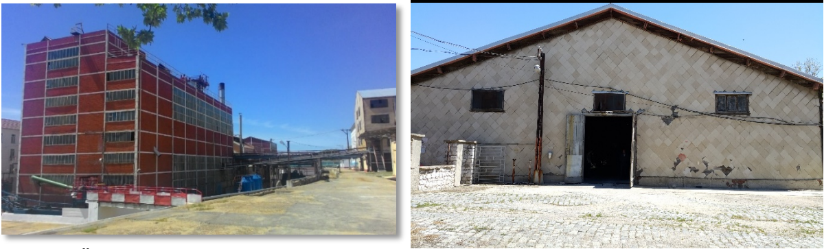
Şekil 9. Üretim ve Ambar Binası (yazarlar arşivi, 2016)
