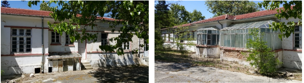
Şekil 8. Hastane Binası ön ve arka görünüşleri (yazarlar arşivi, 2016)
