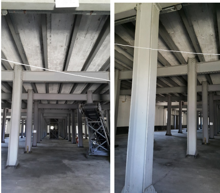
Şekil 8. İşletme binası iç mekân görüntüleri (yazarlar arşivi, 2016)
