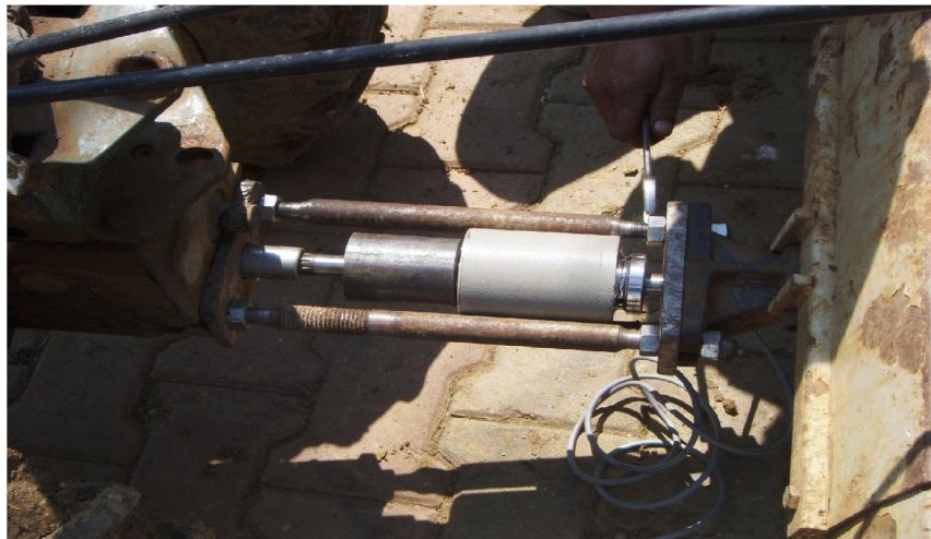
Şekil 3.18. Torkmetre montajının bitmiş hali
