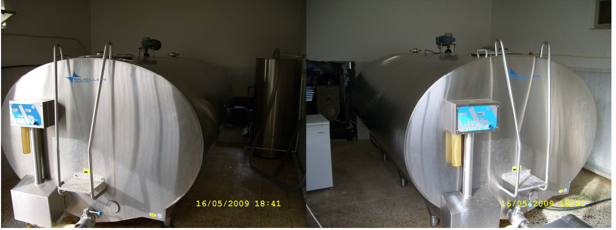
Şekil 11. Sarnıç Köyü Kalkınma Kooperatifi Süt Soğutma Tankı
