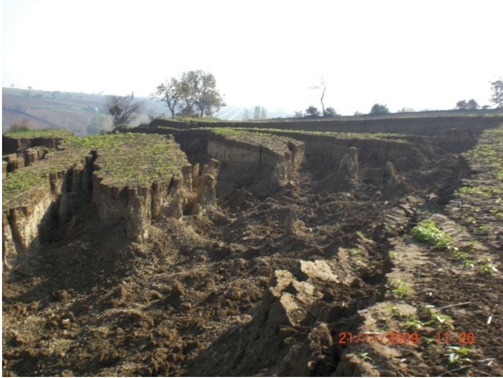
Resim 5.1.2. Araştırma alanında meydana gelen blok halindeki kaymalar
