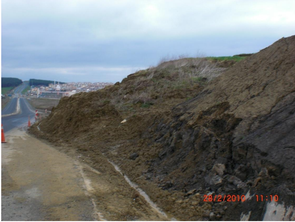
Resim 5.1.5. Arařtırma alanında meydana gelen blok halindeki kaymalar
