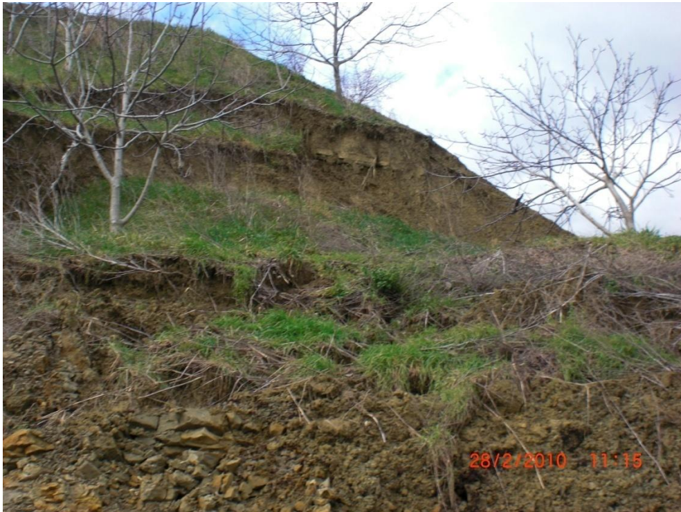
Resim 5.1.6. Arařtırma alanında meydana gelen blok halindeki kaymalar
