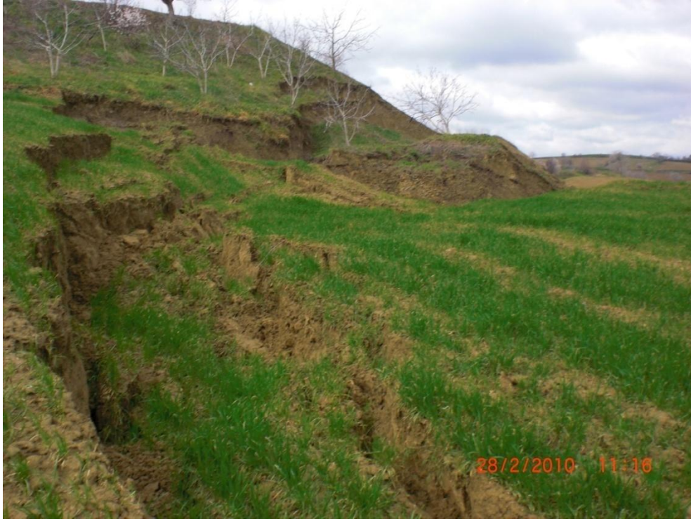
Resim 5.1.1. Araştırma alanında meydana gelen blok halindeki kaymalar
