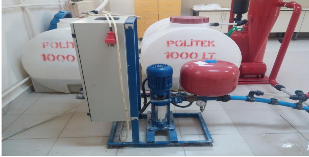
Şekil 3.2. Su deposu ve pompanın görünümü
