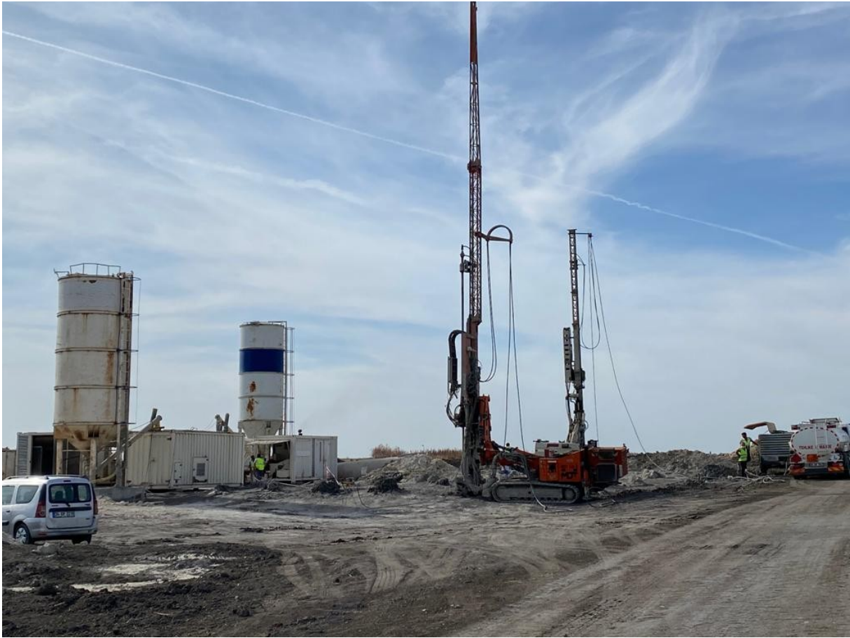
Şekil 1.2: Jet Grout Delgi Makinesi
