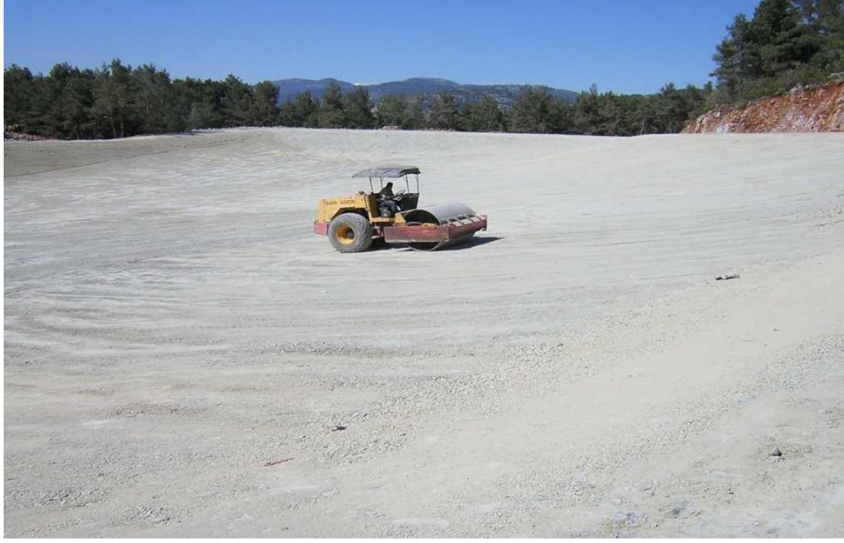
Şekil 2.4. Kil Geçirimsizlik Tabakasının Sıkıştırılması İşlemi
