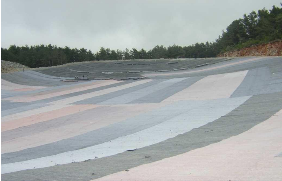
Şekil 2.6. Geotekstilin Serilmesi
