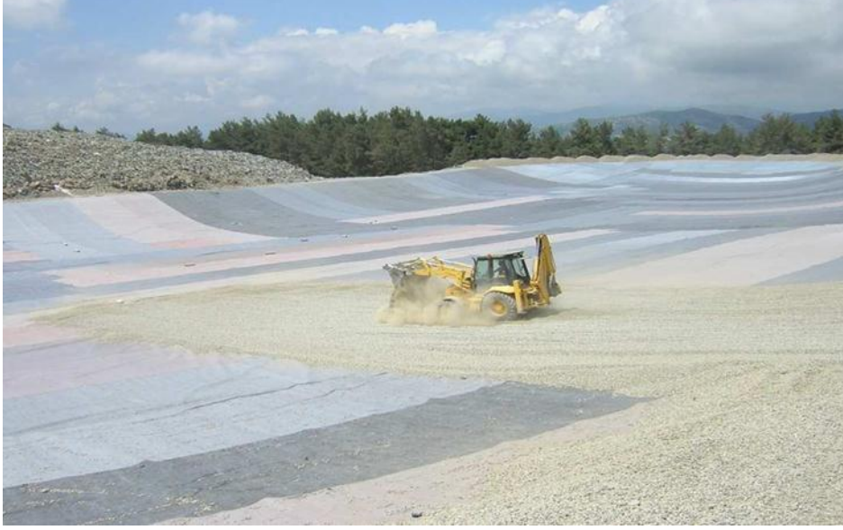
Şekil 2.7. Drenaj İçin Filtre Çakılı Serilmesi
