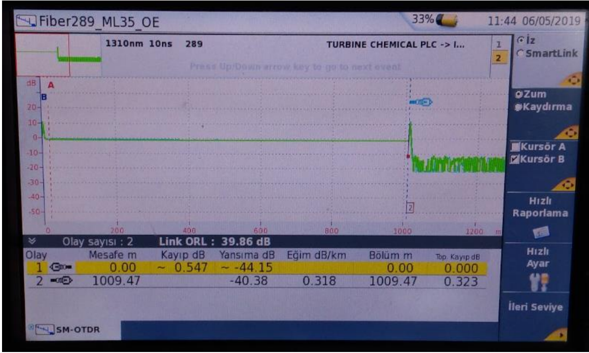
Şekil 4.2. Kablo sonuna kadar kaybını ölçme
