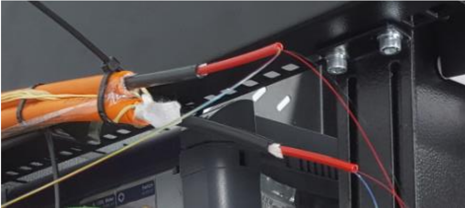
Şekil 4.46. Superonline marka 8 fiberli tek modlu 12mm drop kablo (g657 a2)
