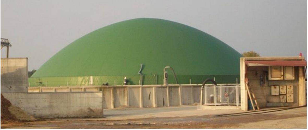
Şekil 4.15. Membran tipi biyogaz tesisi (Anonim 2019ı)
