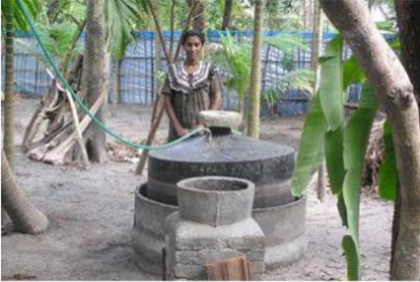
Şekil 2.4. Güney Hindistan’da işletilen 1 m 3 ’lük bir biyogaz sistemi (Güç 2010)
