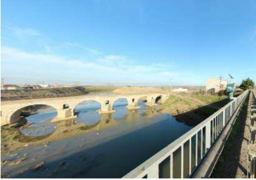
Şekil 5.41. Hayrabolu deresi üzerinde yer alan hacılar köprüsü (Orijinal 2018)
