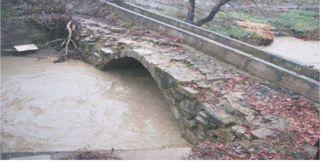
Şekil 5.42. Naip köprüsü (Anonim 2014)
