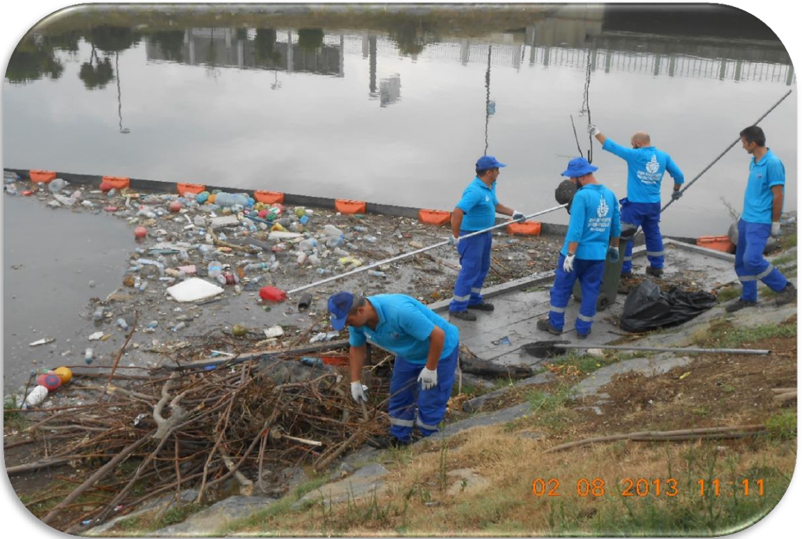
Resim 2.28. Manuel olarak dere bariyerlerinden atıkların alınması (İSTAÇ 2016)
