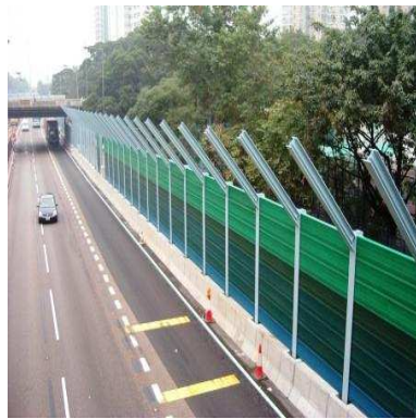
Şekil 2.6. Cansız materyallerle yapılan gürültü perdesi örnekleri (Anonim 2008c)
