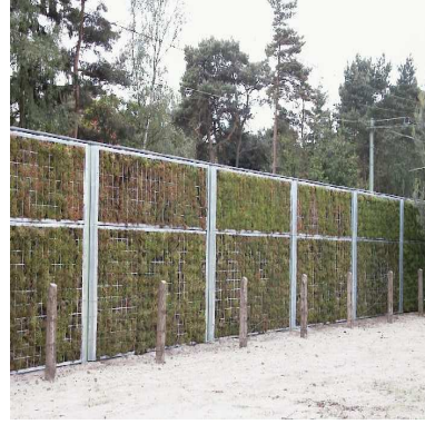
Şekil 2.8. Canlı ve cansız ( kombine) materyallerle yapılan gürültü perdesi örnekleri (Anonim 2008d)
