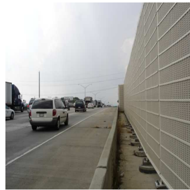
Şekil 2.6. Cansız materyallerle yapılan gürültü perdesi örnekleri (Anonim 2008c)
