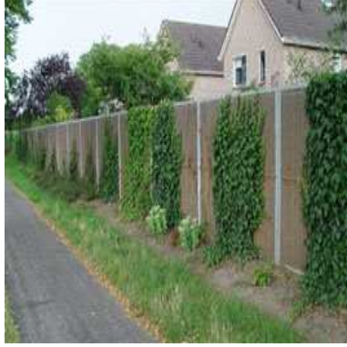
Şekil 2.8. Canlı ve cansız ( kombine) materyallerle yapılan gürültü perdesi örnekleri (Anonim 2008d)
