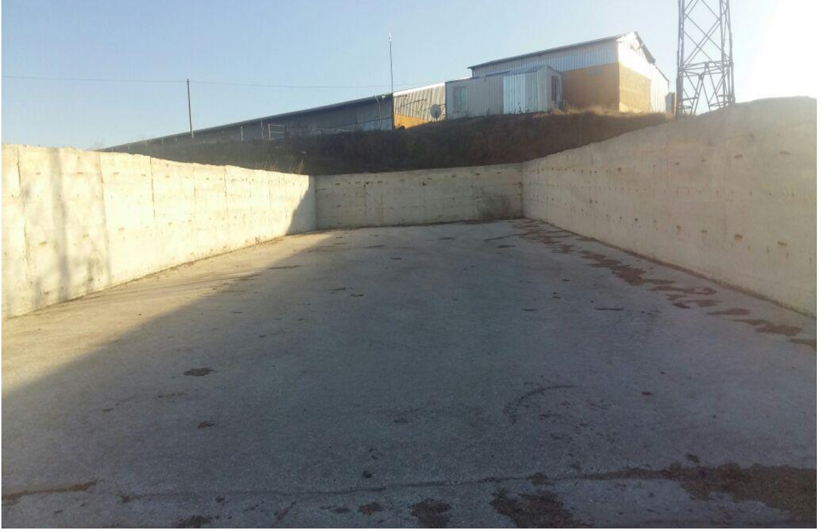
Resim 3. Beton üzeri silolama yapılacak yerin görünümü
