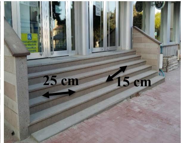
b.)Ertuğrul Mah. PTT binası girişi merdiveni
