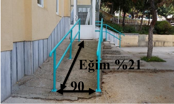
a.)Ertuğrul Mah. Hasan Şekerözü Sok. Rüstempaşa Aile Sağlığı Merkezi girişi rampası:
