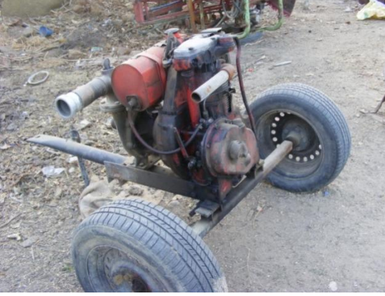
EK 23 Balaban köyü 23 no'lu pompaj tesisi
