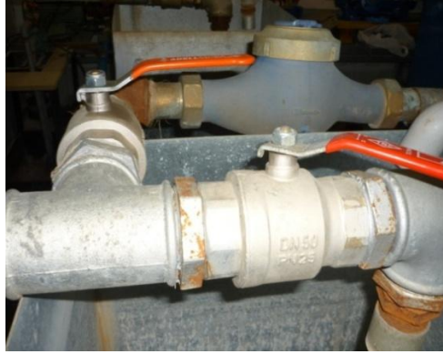
Şekil 3.9. Debi ölçümünde kullanılan kısma vanaları
