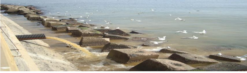
Fotođraf 7. Tekirdađ Sleymanpařa'da kıyıya bořalan kanalizasyonun grnř
