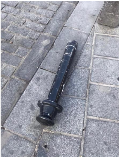
Őekil 4.30. Emin n  Meydanı'nda bulunan vandalizme uđramıő otopark sınırlayıcı bariyer (Orijinal)
