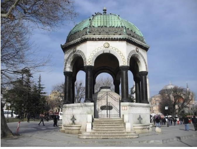
Şekil 2.17. Sultanahmet Meydanı-Alman Çeşmesi/İstanbul (URL15)
