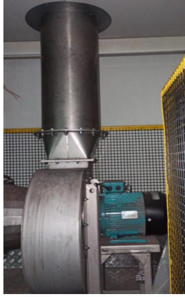
Şekil 3. 5. Atık ısının dışarı atılmasındaki baca gazı çıkış bağlantısı.
