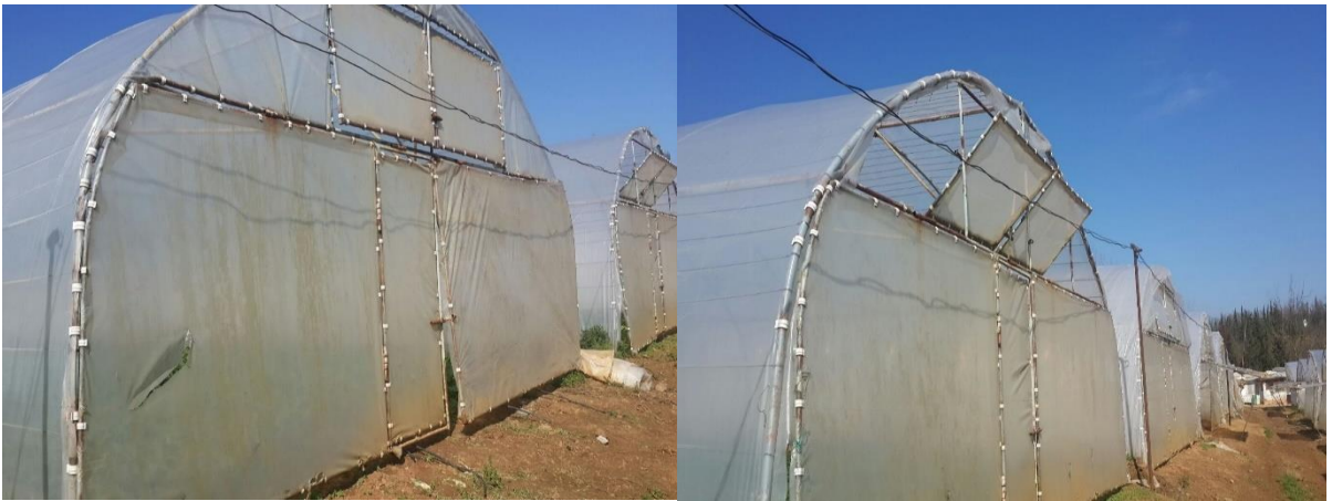
Şekil4.24. Ülkemizde kullanılan plastik örtü malzemesinin yüksek tünel konstrüksiyonuna mandalla sabitlenmesi (Pendik/ Göçbeyli, 2016)
