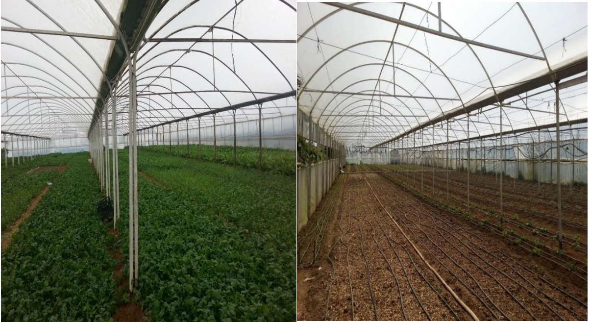
Şekil 4.8. Yay çatılı sistem seranın iç görünüşü (Sarıyer / Gümüşdere, 2015)
