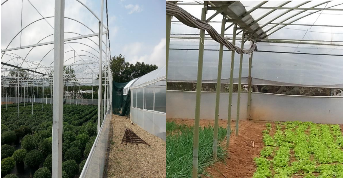
Şekil 4.11. Korozyona karşı yağlı boya ve antipas kullanımı (Sarıyer / Gümüşdere, 2015)
