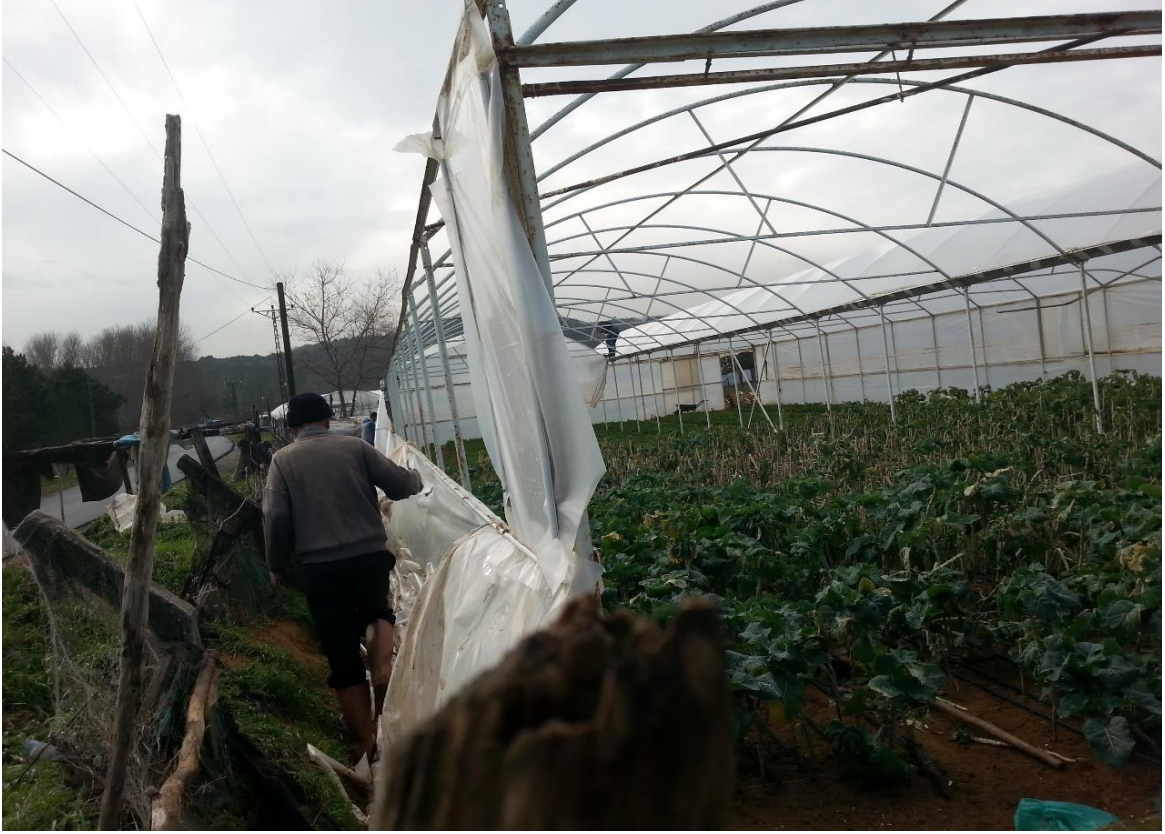
Şekil 4.44 Bakım ve onarım çalışması yapılan yay çatılı sera (Sarıyer / Gümüşdere, 2015)
