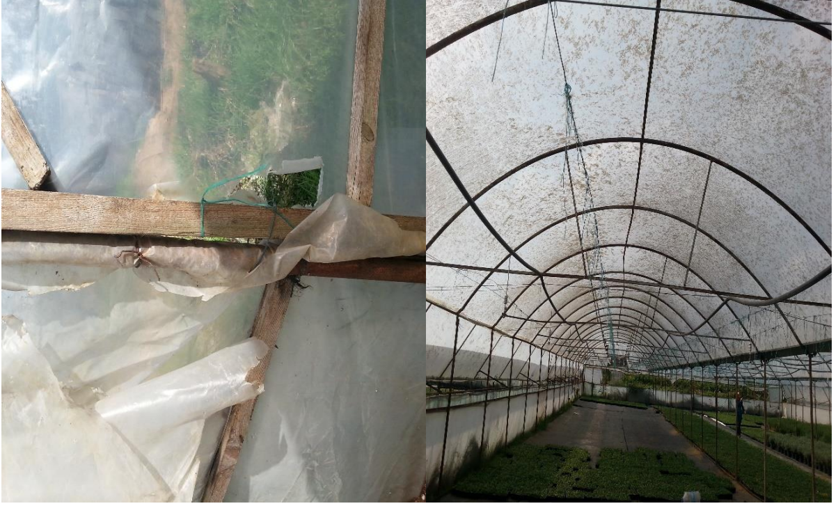
Şekil 4.25. Plastik örtü malzemesinin çiviyle çakılması sonucunda oluşan yırtılma ve örtü malzemesindeki kirlenme (Sarıyer/ Gümüşdere, 2015)
