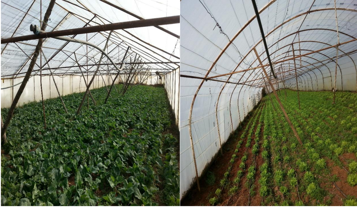
Şekil 4.9. Yüksek tünel çatı sisteminin dikmelerle desteklenmesi (Pendik / Göçbeyli, 2015)
