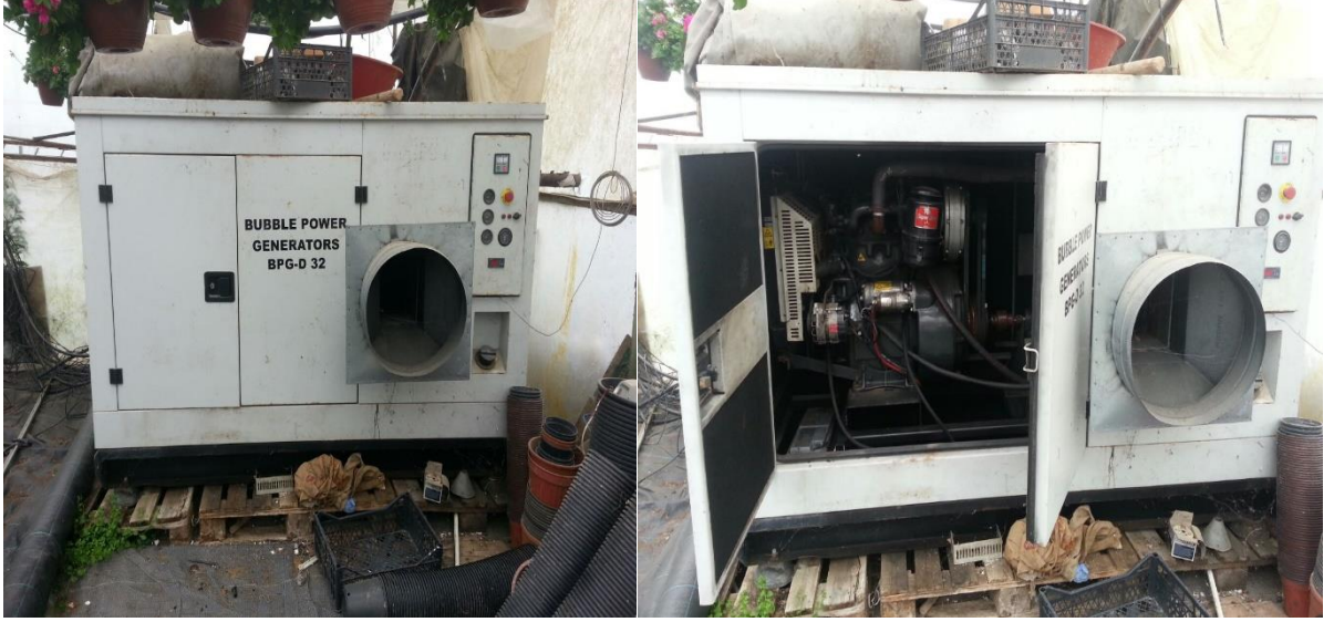
Şekil 4.39. Plastik örtülü serada sıcak hava üflemeli ısıtma sistemi (Sarıyer / Gümüşdere, 2015)
