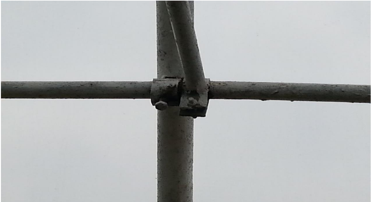
Şekil 4.18. Yay çatılı sistem serada metal malzemelerinin bulonla birleştirilmesi (Sarıyer / Gümüşdere, 2015)
