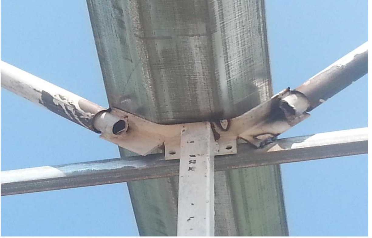
Şekil 4.15. Yay çatılı sistem serada çatı malzemelerinin kaynakla birleştirilmesi (Sarıyer / Gümüşdere, 2015)
