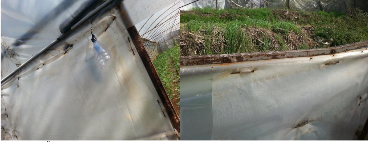
Şekil 4.22. Ülkemizde kullanılan plastik örtü malzemesinin sera konstrüksiyonuna çiviyle sabitlenmesi (Sarıyer / Gümüşdere, 2015)
