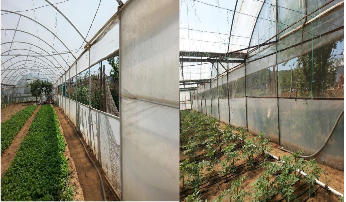
Şekil 4.27. Plastik örtülü seralarda yan duvar havalandırması (Sarıyer/ Gümüşdere, 2015)
