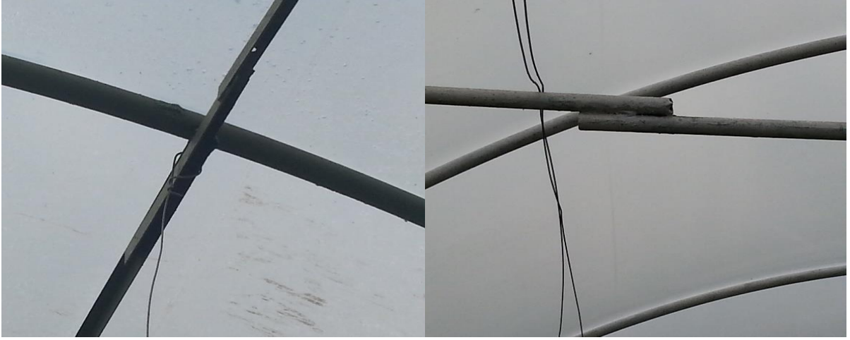
Şekil 4.19. Yay çatılı sistem serada metal malzemelerinin kaynakla birleştirilmesi (Sarıyer / Gümüşdere, 2015)
