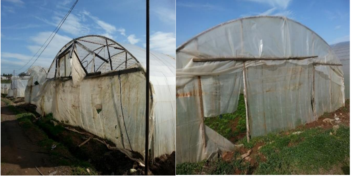
Şekil 4.5. Yay çatılı serada ahşap ve demir malzemenin beraber kullanıldığı yüksek tünel sistemi dış görünüşü (Pendik / Göçbeyli, 2016)
