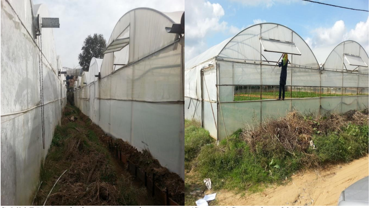
Şekil4.7 Yay çatılı sistem seranın dış görünüşü (Sarıyer / Gümüşdere, 2015)
