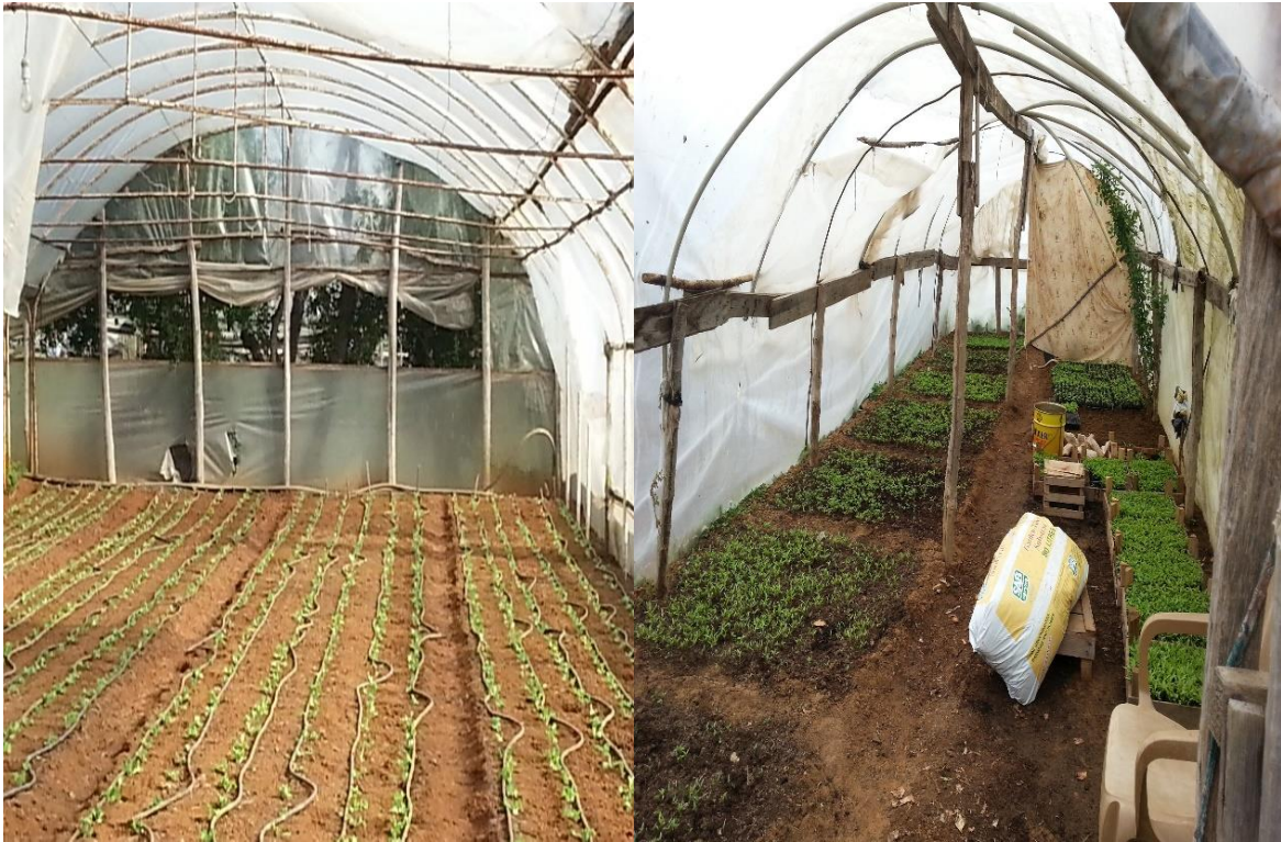
Şekil 4.4. Yay çatılı ahşap ve demir malzemenin beraber kullanıldığı sera sistemi iç görünüşü (Sarıyer / Gümüşdere, 2015)
