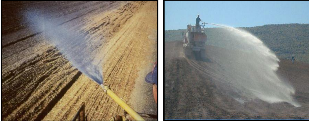
Şekil 2.19. Spreyleme anından görünüm (Çetinkaya 2005)
