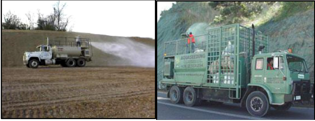
Şekil 2.18. Tohum ekimi makinelerinin uygulamasından bir görünüm (Çetinkaya 2005)
