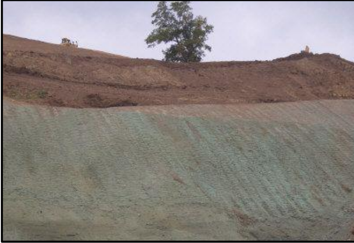
Şekil 2.17. Hydroseeding uygulanmış ve uygulanmamış alandan görünüm (Çetinkaya 2005)
