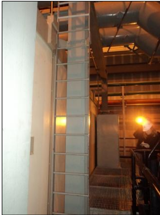
Fotoğraf 4.17: Santralin İşletme Binasında Yer Alan Merdiven
