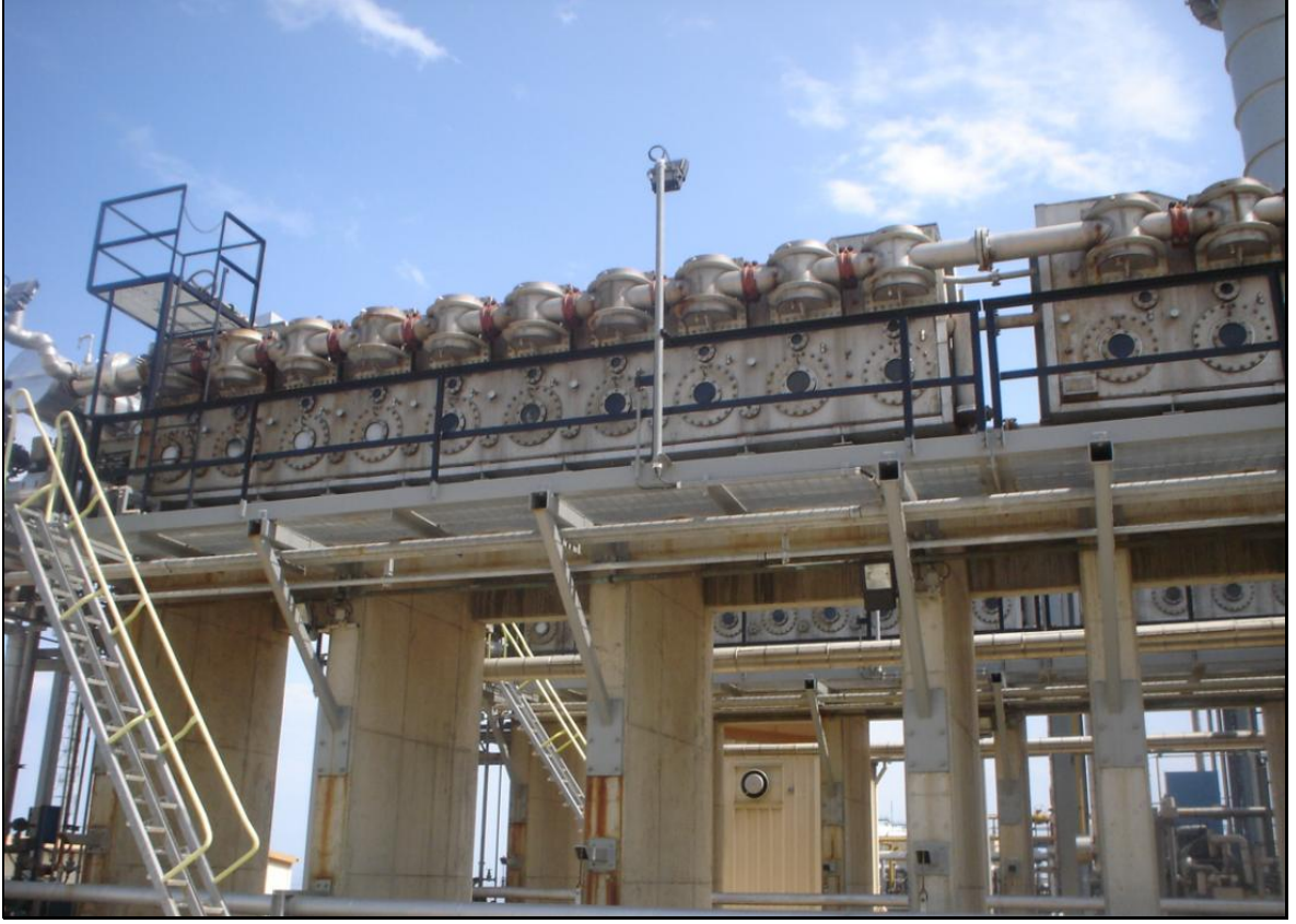
Fotoğraf 3.13: Deniz Suyu Evaporatörü
