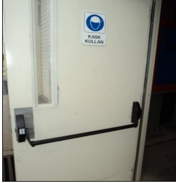
Fotoğraf 4.14: Santralde yeralan kapılar
