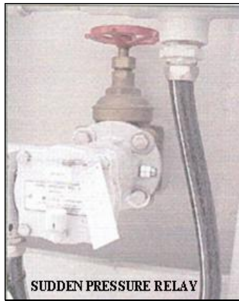
Fotoğraf 3.9: Trafo Koruma Elemanları
