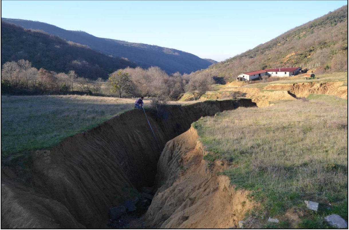
Foto 3: İnceleme sahasındaki derin hendeklerden bir görünüm
