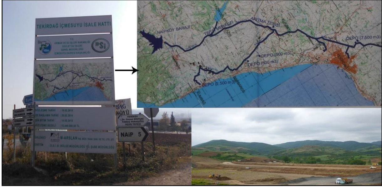
Foto 1: İnceleme sahasındaki Tekirdağ içmesuyu isale hattı ve Naipköy barajından bir görünüm
