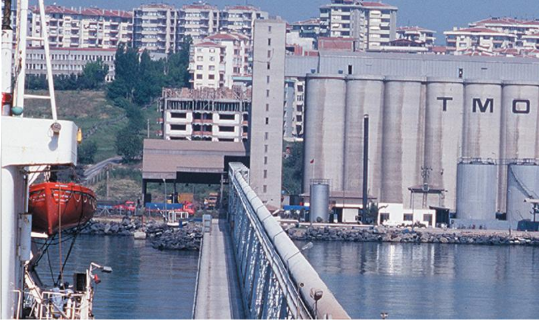
Şekil 5. Tekirdağ toprak mahsulleri ofisi betonarme silosundan genel bir görüntü
