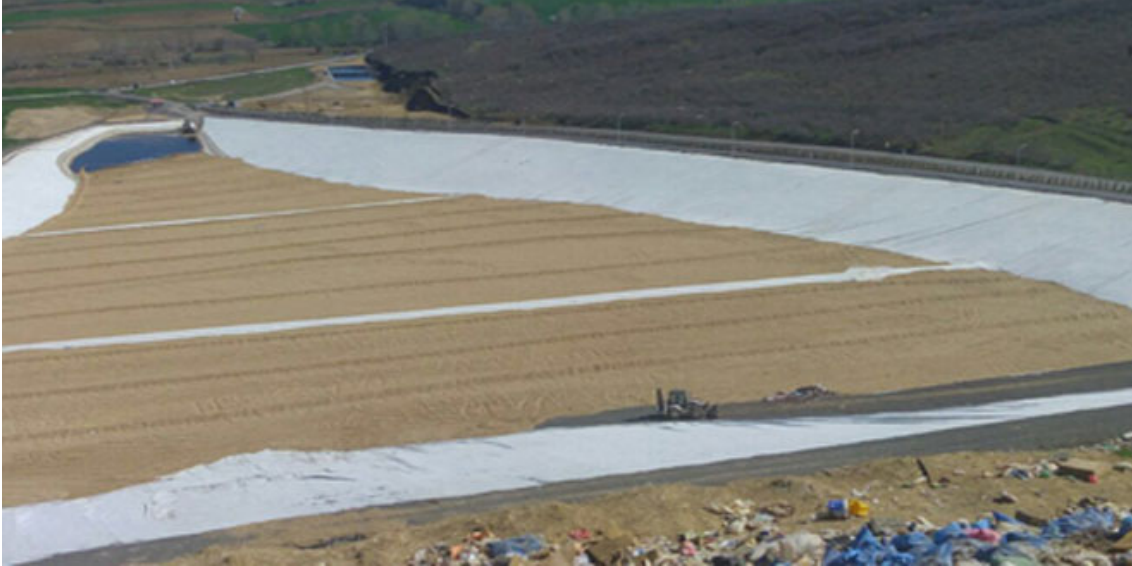
Şekil 2.11. Demirli Katı Atık Düzenli Depolama Tesisi lot alanı
