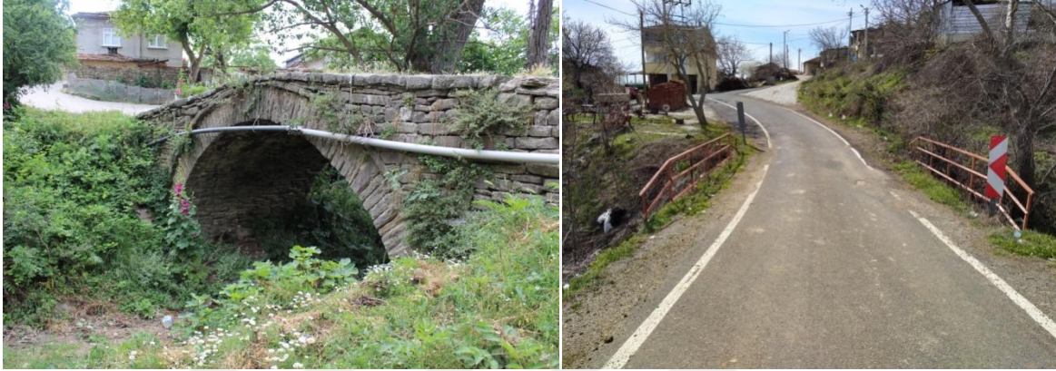
Şekil 4.77. Tarihi Taş Köprü (Sol), Güzelköy girişindeki köprü (Sağ)
