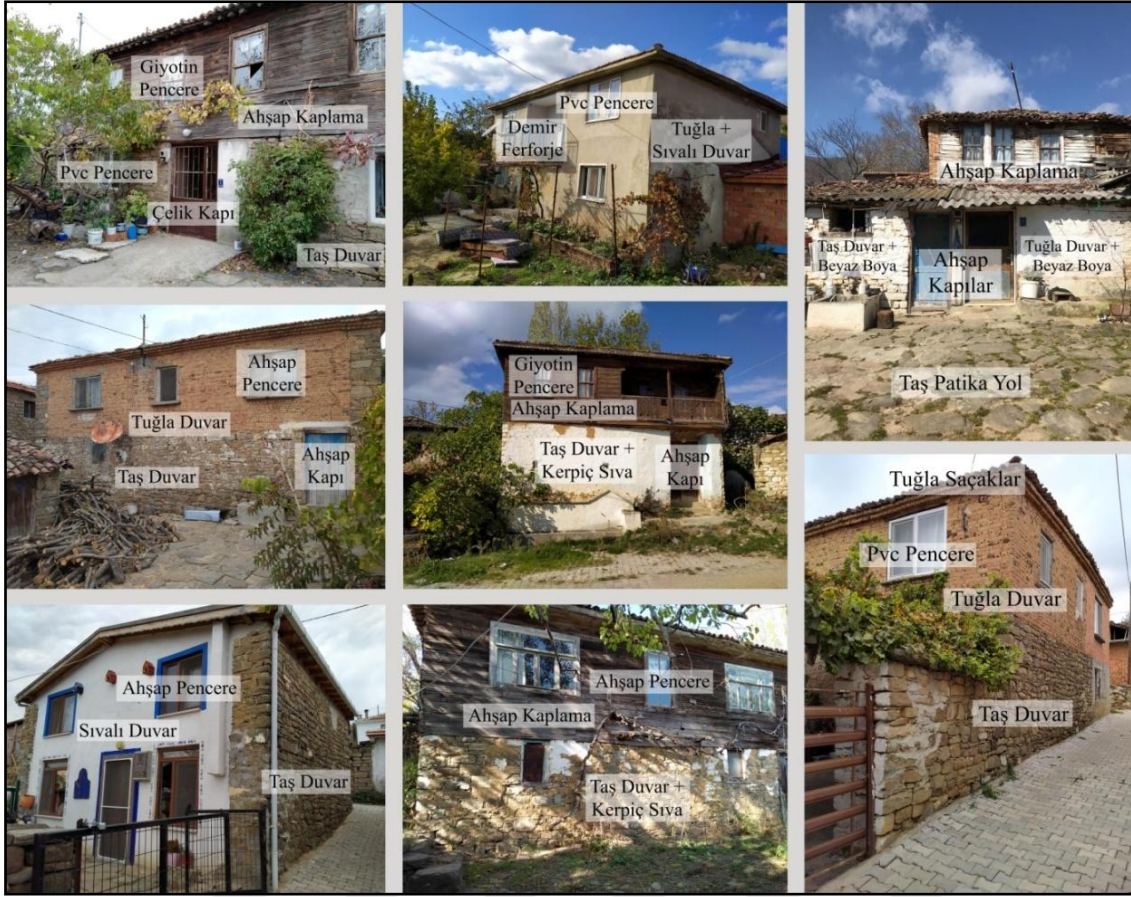
Şekil 4.103. Güzelköy geleneksel mimari doku içerisinde yer alan yapı cephe görselleri
