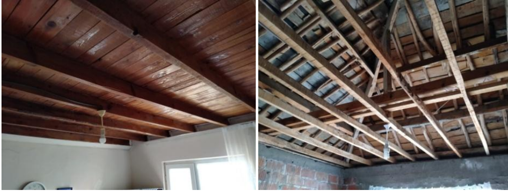
Şekil 4.100. Normal kat ahşap döşemesi ve ahşap çatı taşıyıcı elemanları
