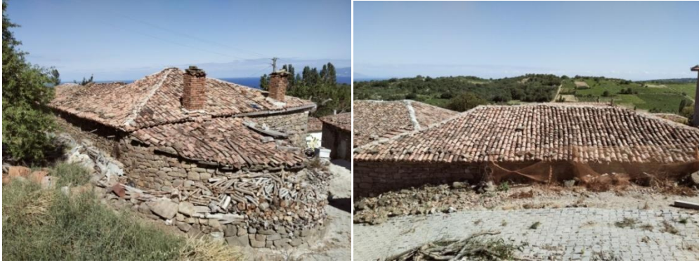
Şekil 4.109. Alaturka çatı kaplaması örnekleri
