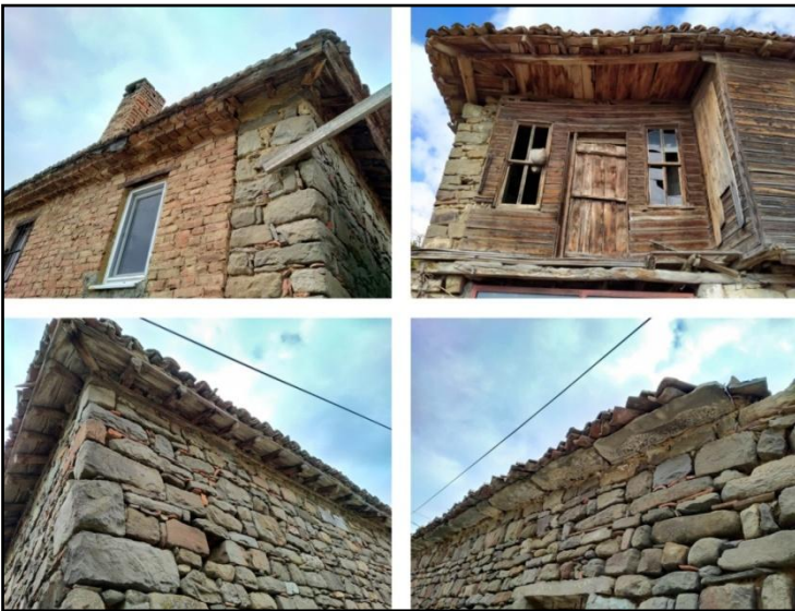
Şekil 4.111. Çatı saçağı örnekleri
