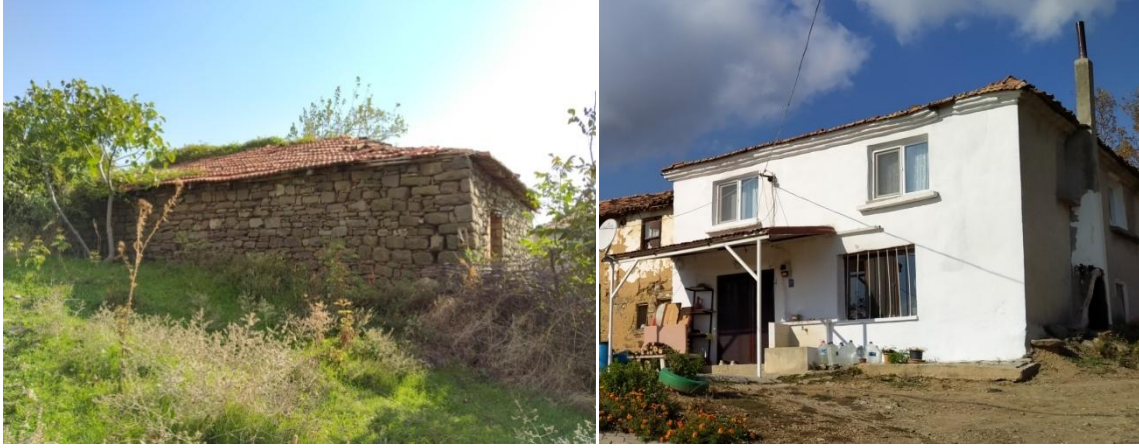
Şekil 4.54. Taş yığma yapı örneği (Sol) ve tuğla yığma yapı örneği (Sağ)
