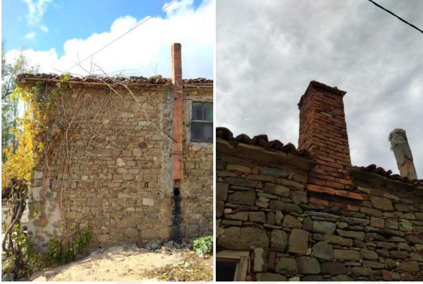
Şekil 4.108. Cephede baca ve tuğladan yapılmış baca örneği
