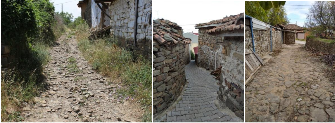
Şekil 4.76. 3. kademe yollar (patikalar) sırasıyla taş + toprak, kilit taş ve doğal taş malzeme yol örnekleri
