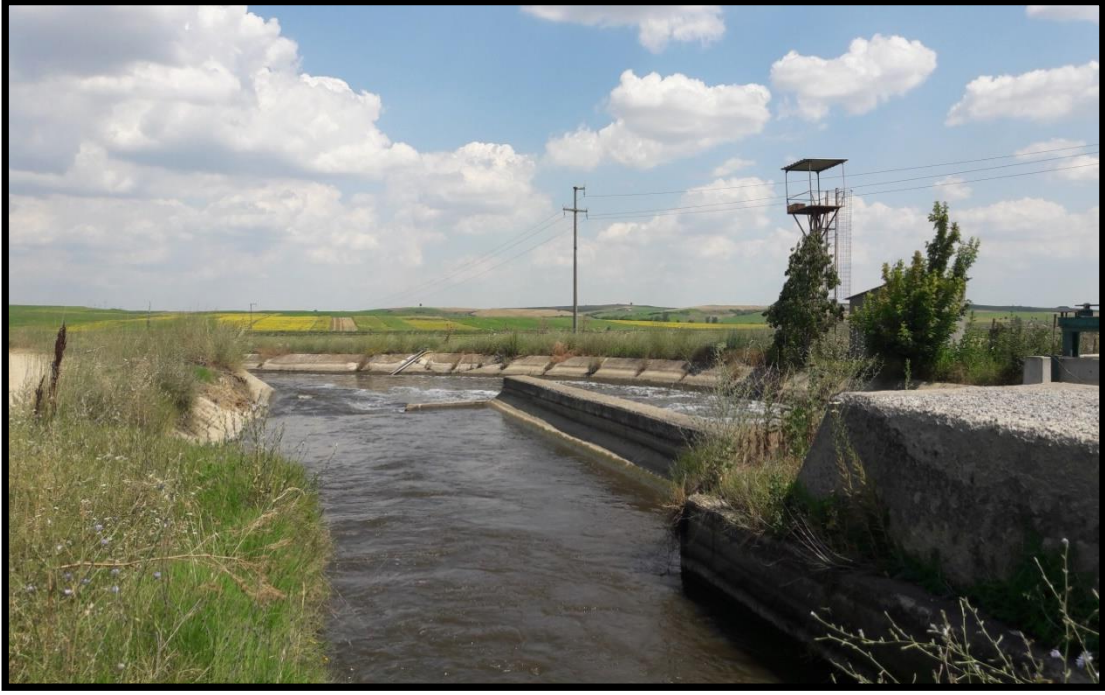
Şekil 4.33. Anakanalın kollarının ikiye ayrıldığı Sultan köyü istikametindeki görünüm
