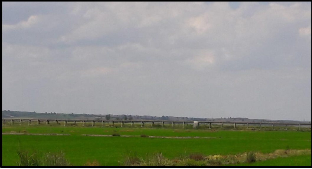
Şekil 4.17. Balabancık köyü ayaklı kanaletler
