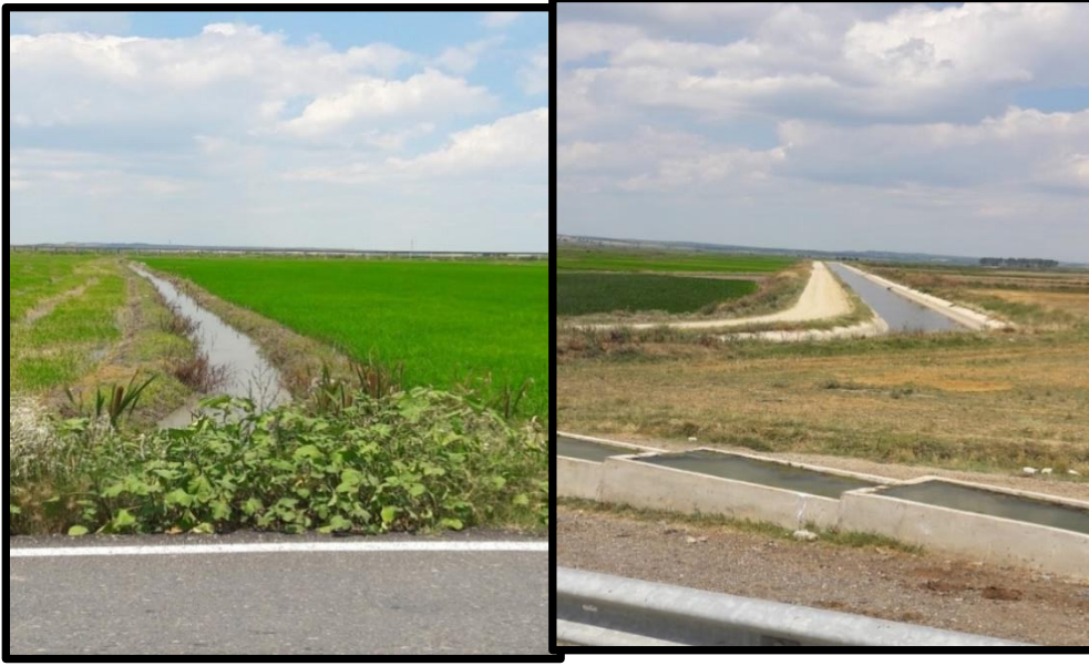
Şekil 4.18. Balabancık köyü toprak kanal
