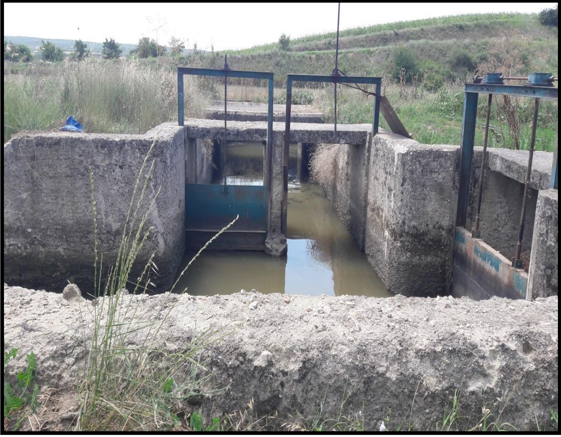
Şekil 4.25. İki kanalın birleştiği yerden görünüm
