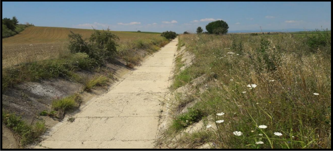
Şekil 4.23. Karaağaç köyü beton kaplamalı ana kanal
