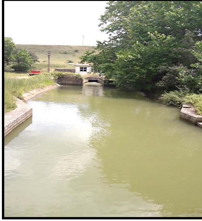
Şekil 3.15. Sultanköy barajı dağıtım noktası çıkışı
