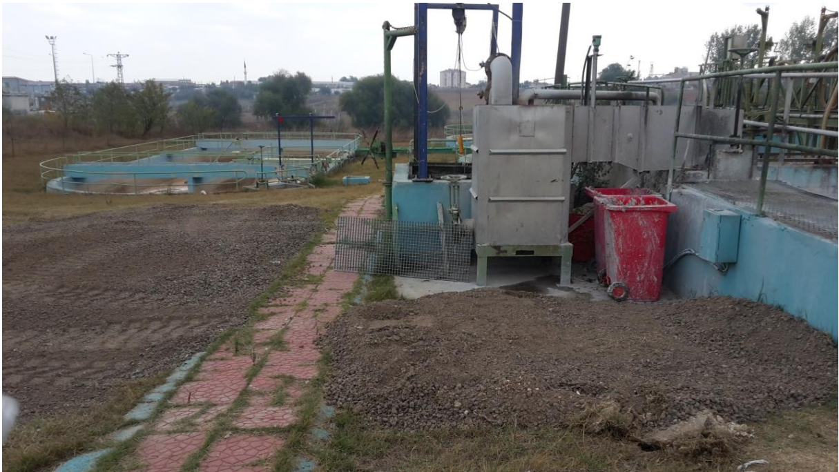
Şekil 3.5. Proses terfi tankı
