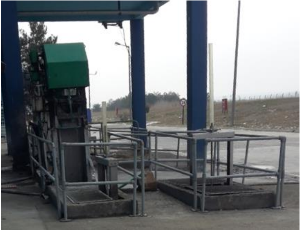
Şekil 3.4. Kaba- ince mekanik temizlemeli ızgaralar
