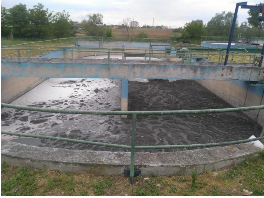
Şekil 3.10 Dengeleme tankı
