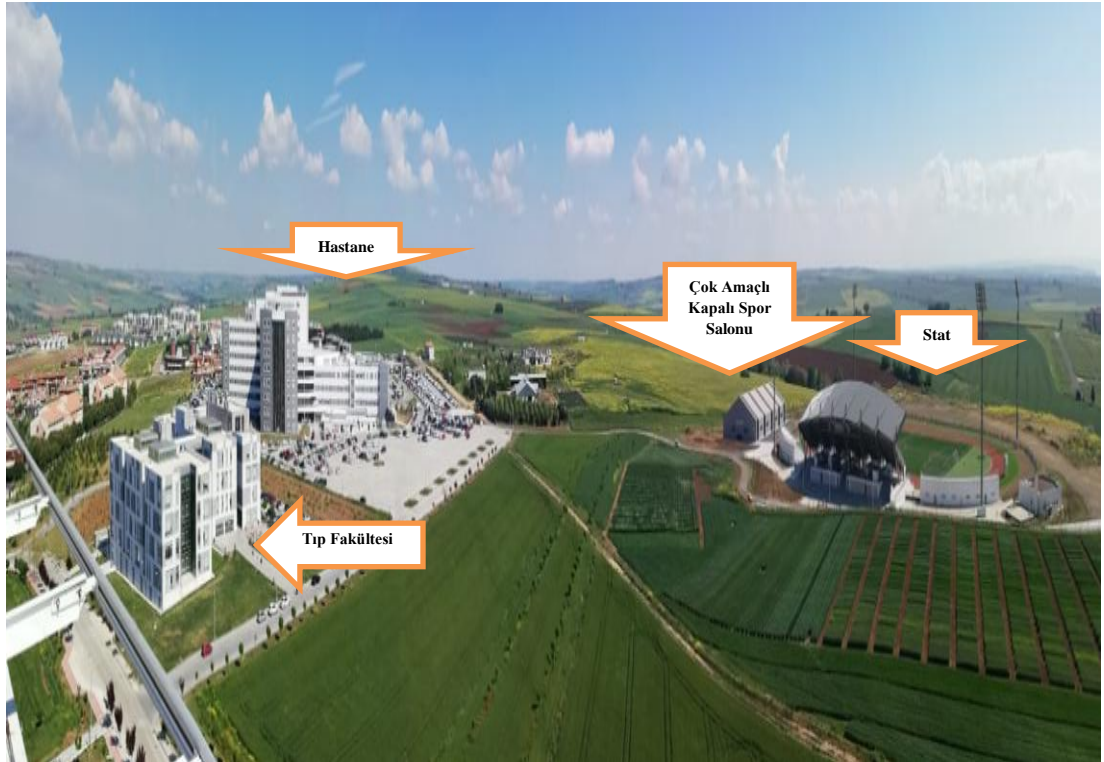
Şekil 6.15: Rektörlük Binasından Hastaneye ve Stada Ait Görüntü
