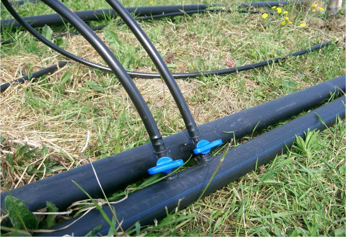
Şekil 3.5. Sulama hatları döşendikten sonra lateral bağlantılarını gösteren bir görüntü
