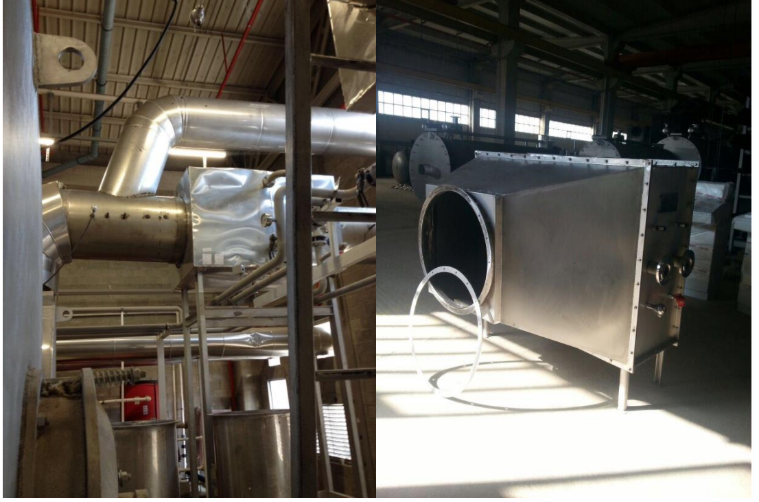
Şekil 5.4 Ekonomizer Montajı
