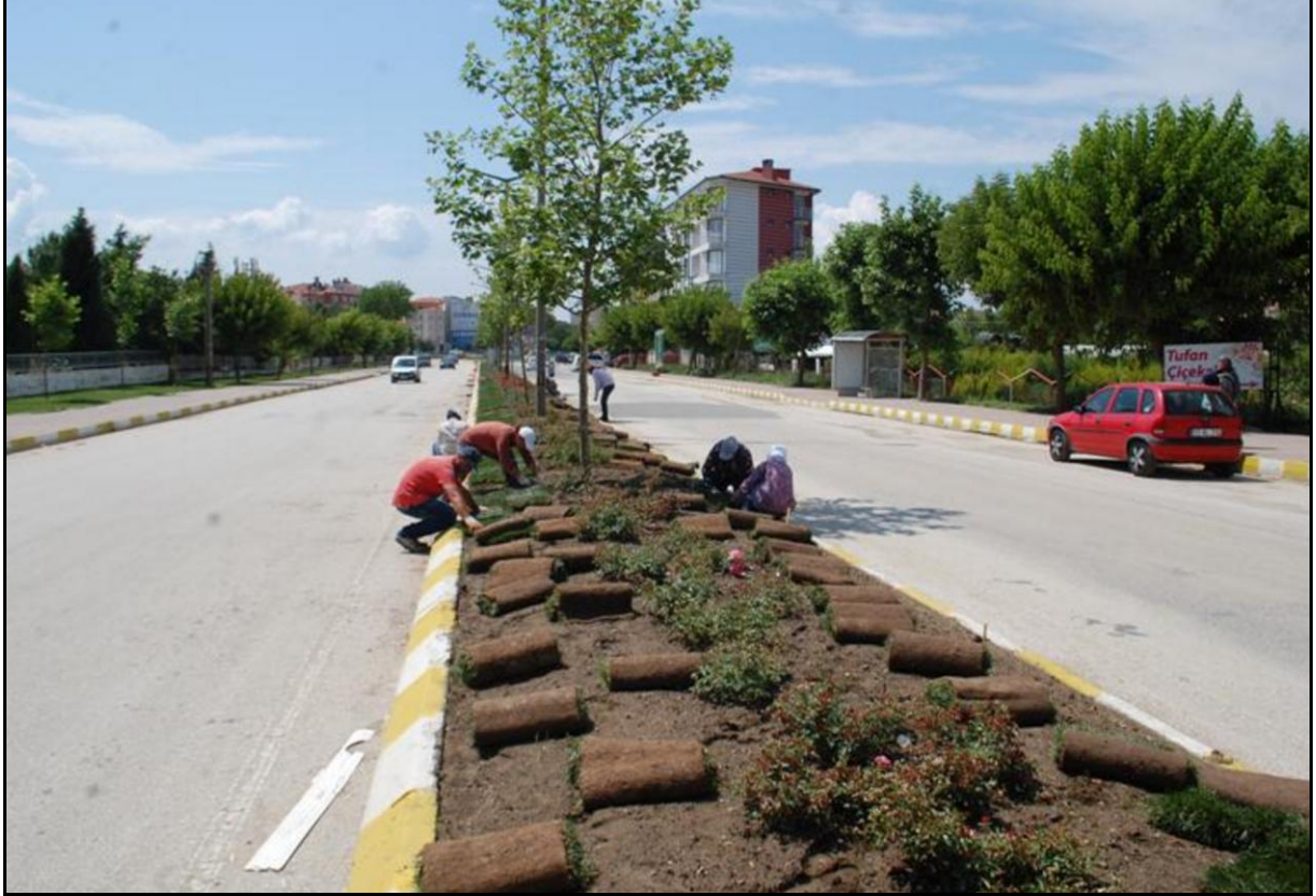
Şekil 2.5. Orta refüjde hazır çim uygulaması (Anonim 2016a)
