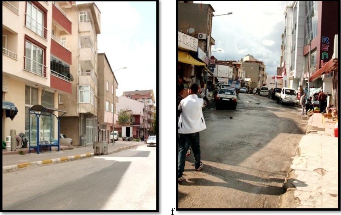
Şekil 5.7e,f. İnşaat çalışmaları nedeniyle yok edilmiş ağaçlar
