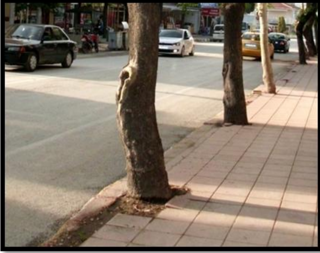
Şekil 5.5. Ağaç köklerinin havalanmasını sağlayan ızgaraların bulunmadığı yanlış örnekler
