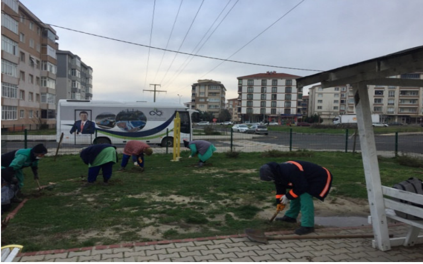
Şekil 4.11.Yağmur bahçesi uygulama alanı yer hazırlığı (Foto: Yasemin Duygu BOLAT, Eylül 2020)
