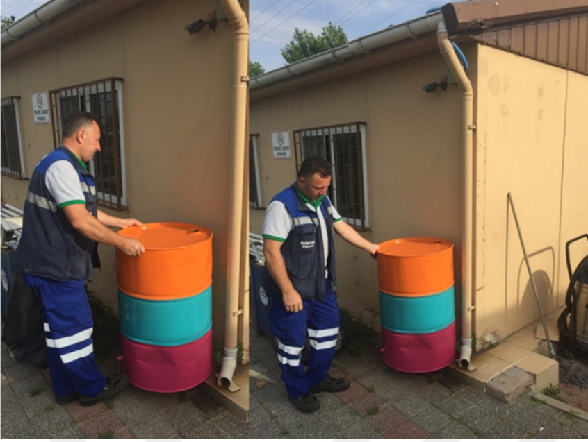
Şekil 4.18. Yağmur suyu depolama tankının yerleştirilmesi (Foto: Yasemin Duygu BOLAT, Nisan, 2021)
