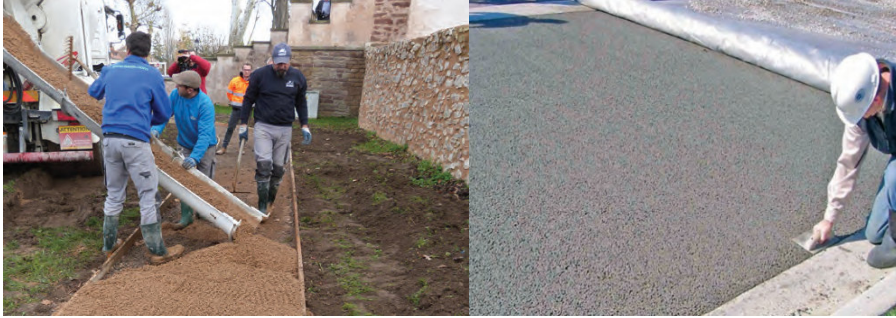
Şekil 2.4.Geçirimli beton kaplamanın yerleştirilmesi ve sıkıştırılması (T.C. Çevre ve Şehircilik Bakanlığı, Türkiye Hazır Beton Birliği, 2018)
