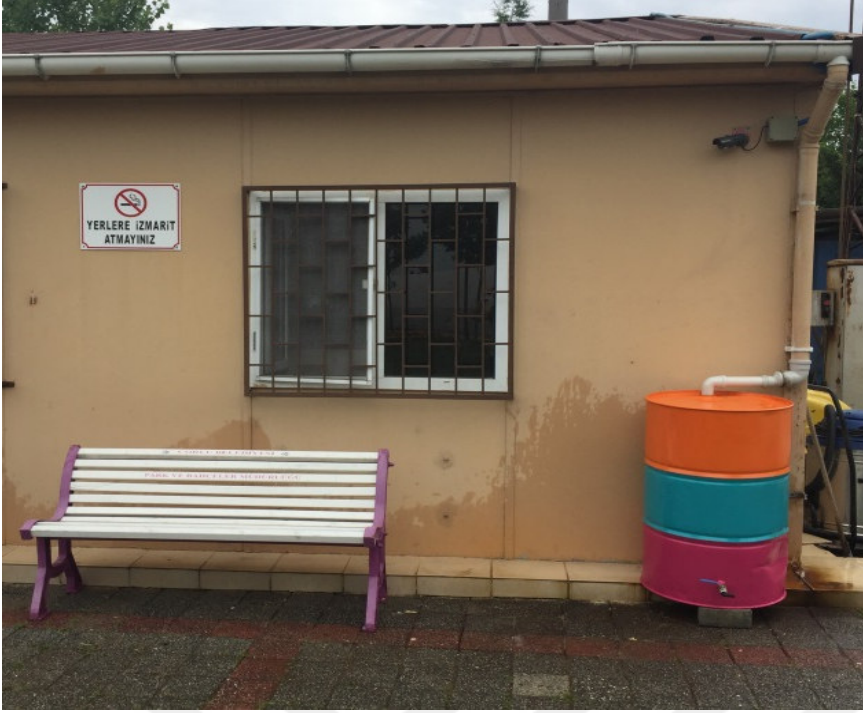
Şekil 5.5. Yağmur suyu toplama tankı montaj sonrası (Foto: Yasemin Duygu BOLAT, Nisan, 2021)
