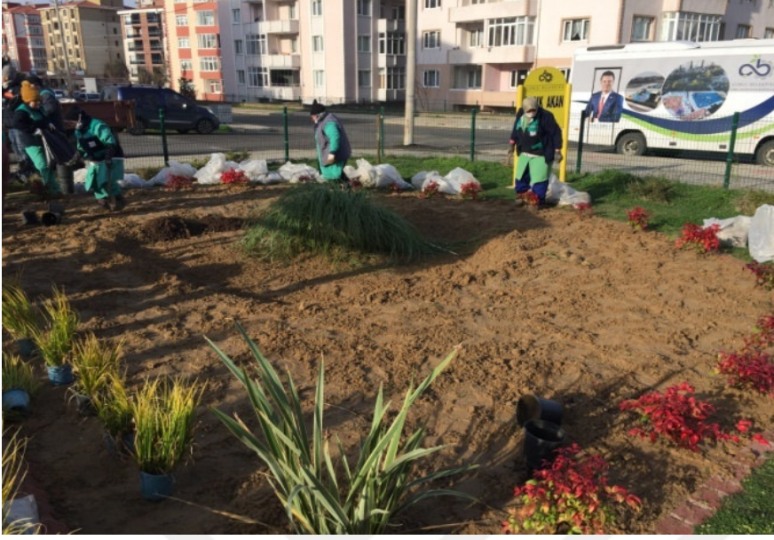
Şekil 4.13. Yağmur bahçesi uygulama alanı dikim aşaması (Foto: Yasemin Duygu BOLAT, Eylül 2020)
