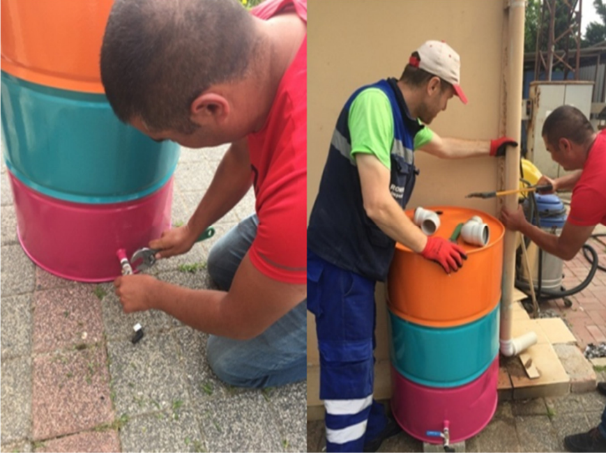
Şekil 4.19. Yağmur suyu toplama tankının bağlantılarının yapılması (Foto: Yasemin Duygu BOLAT, Nisan 2021)
