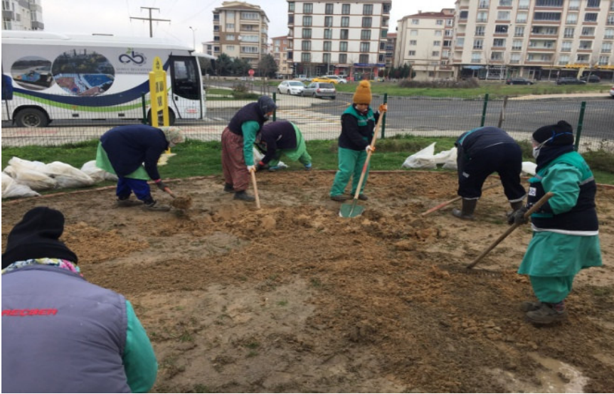
Şekil 4.12.Yağmur bahçesi uygulama alanı yapım aşaması (Foto: Yasemin Duygu BOLAT, Eylül 2020)
