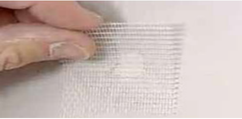
Şekil 2.47. Sıva yamalarında leno yapışır bant (UTİB ve Butekom 2011)
