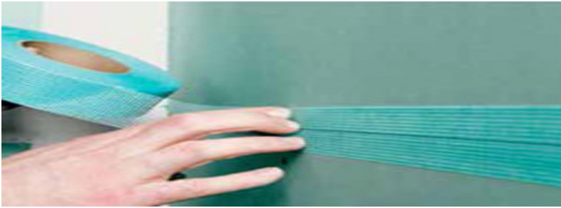
Şekil 2.45. Eklemeli duvarlar için leno yapışır bant (UTİB ve Butekom 2011)
