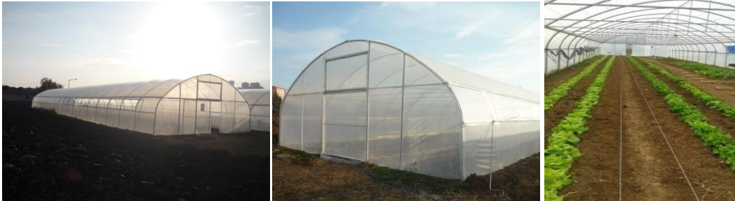
Şekil 1. Çalışmada kullanılan gotik çatılı yüksek plastik tünelin dış ve iç görüntüsü
