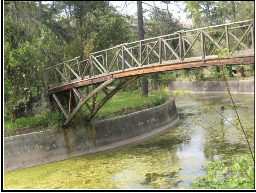
Şekil 4.103. Köprünün genel görünümü
