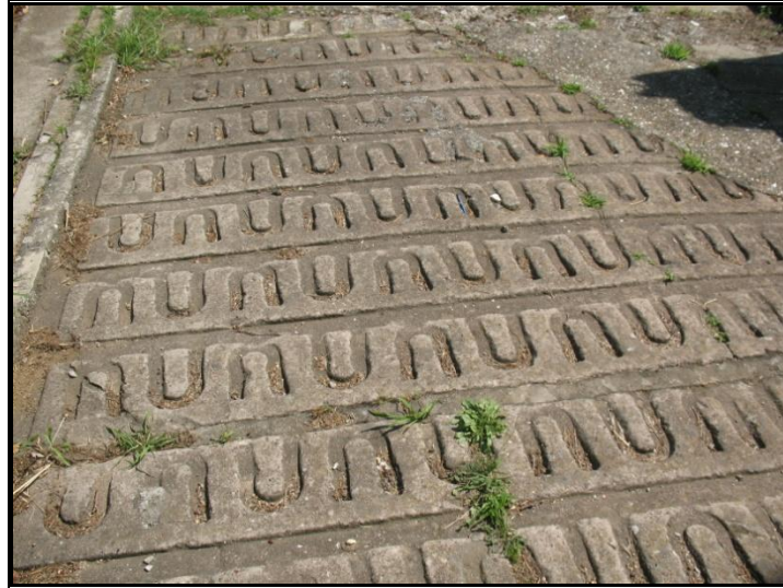
Şekil 4.70. Nal desenli baskı beton yol
