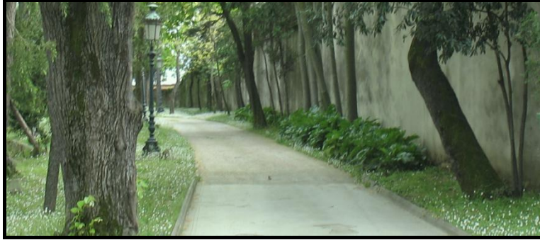
Şekil 4.23. Baskı beton-grobeton geçişi
