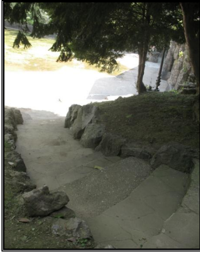
Şekil 4.72. Kayık duraklarına inen merdiven
