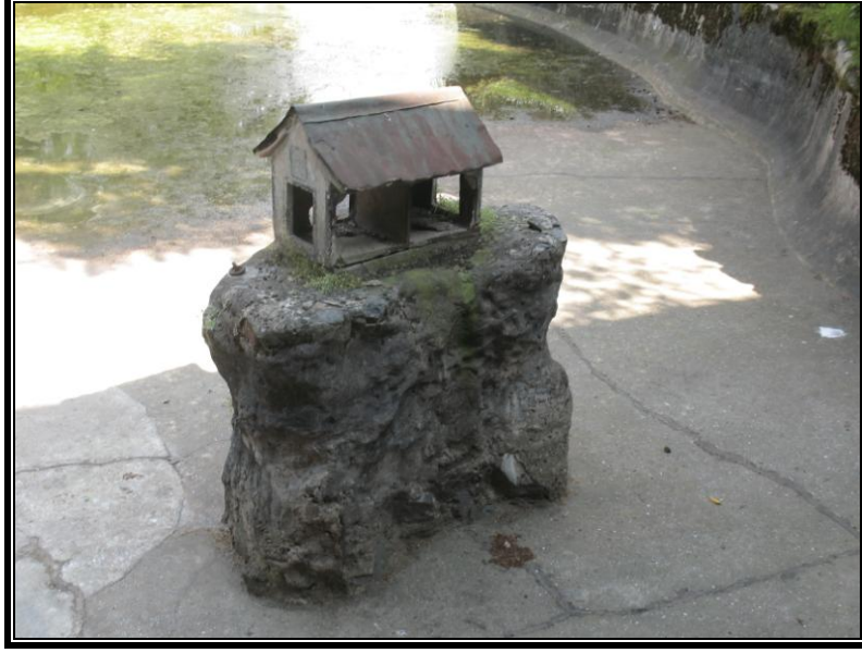
Şekil 4.105. Havuz taban çatlakları
