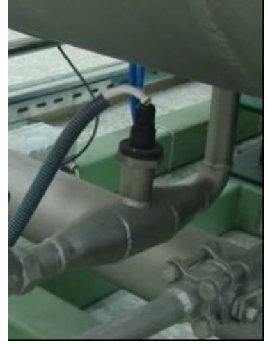
Şekil 5.7 Su Seviye elektrotu
