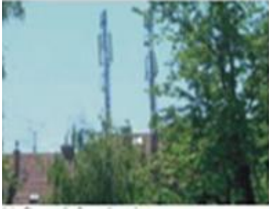
a-Cep telefonu baz istasyonu
