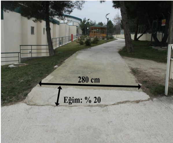
a.) Spor kompleksi binasının arka yolu
