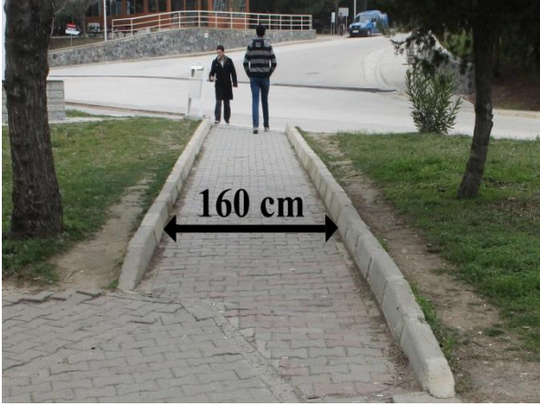
e.) Çamlık kafeye giden yürüyüş yolu
