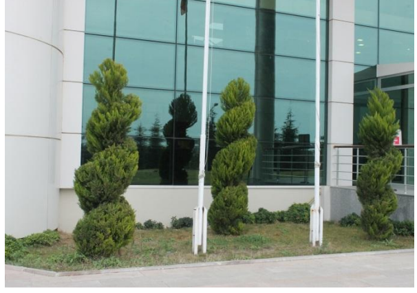
b.) Spor kompleks bina önü alan
