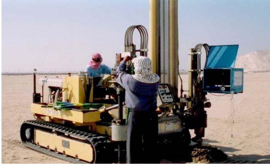
Şekil 3.5. Koni Penetrasyon Aletinin Taşınması ve Ankrajlarla Zemine Sabitlenmesi
