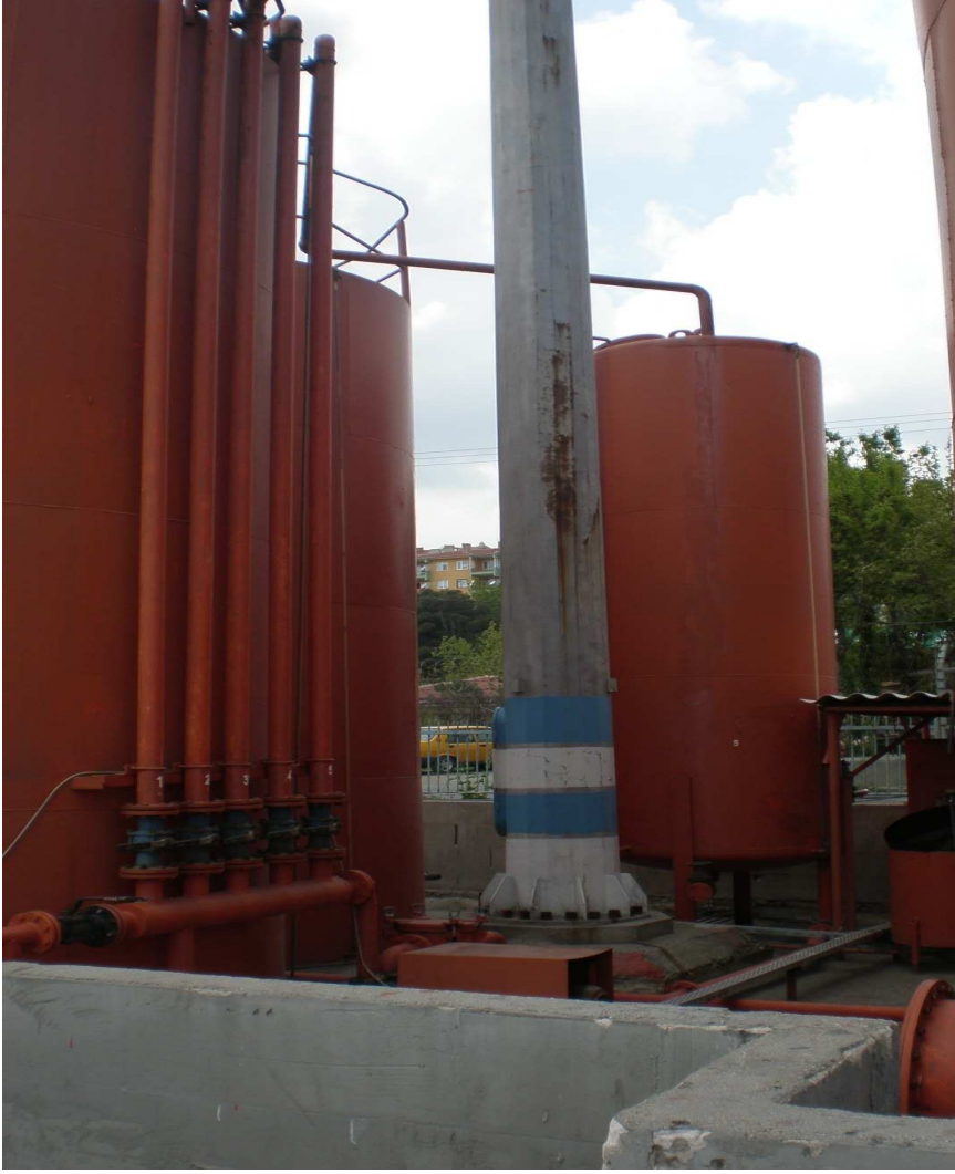
Atık Kabul Tesisi
