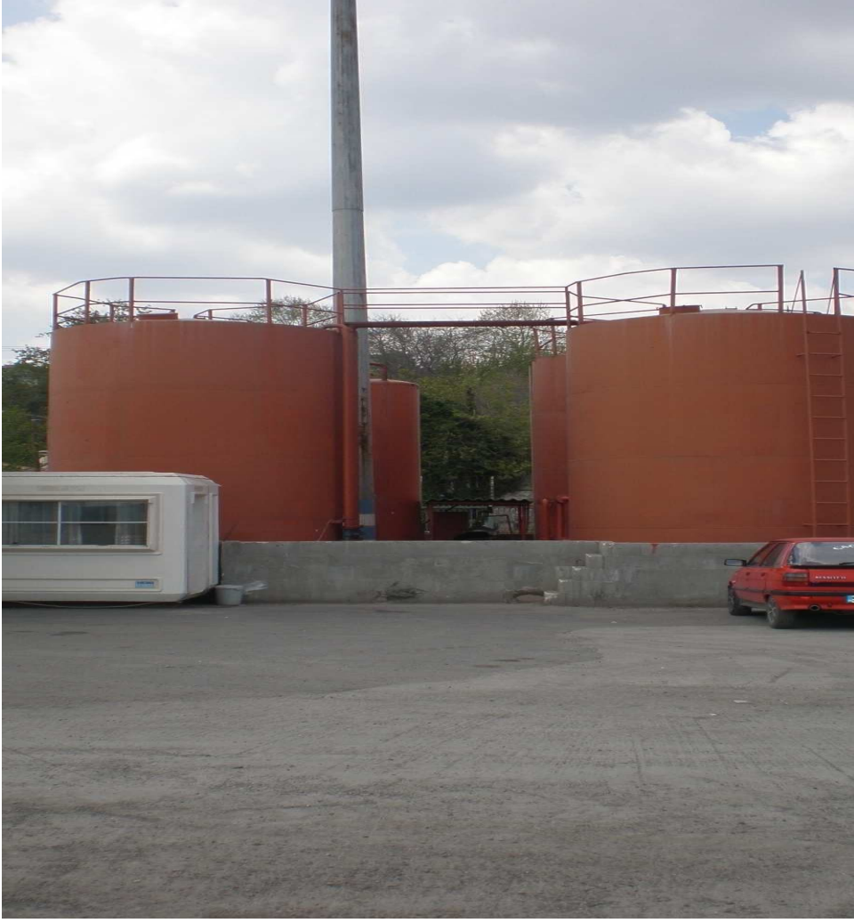
Atık Kabul Tesisi
