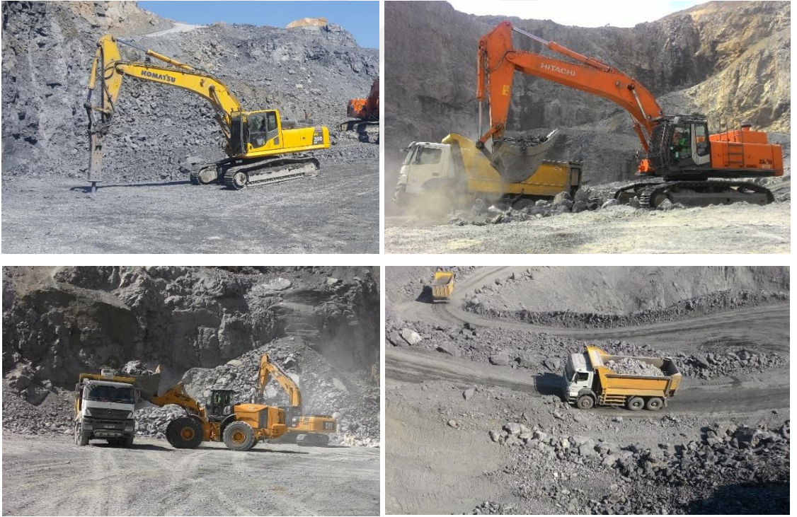
Şekil 3.9. Ocak Tabanından Tesislere Malzemenin Çıkarılma Süreci
