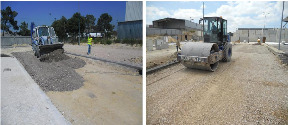
Şekil 5.8. Geri dönüştürülmüş agregaların serilmesi ve sıkıştırılması (Neves vd., 2013)
