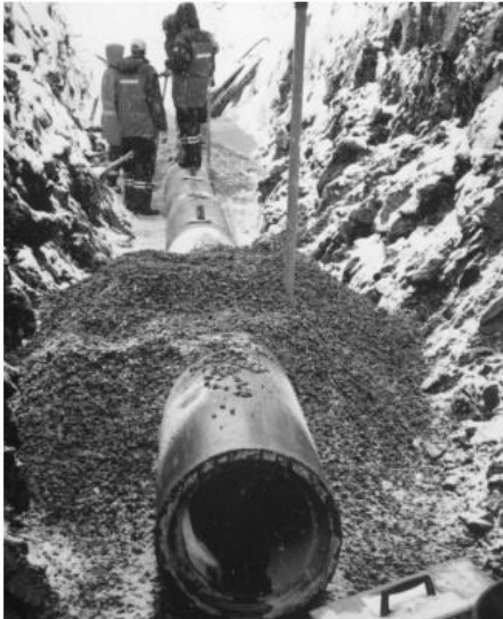
Şekil 5.4. Drenaj kanalı geri dolgusu olarak kullanımı (Mehus vd., 2003)
