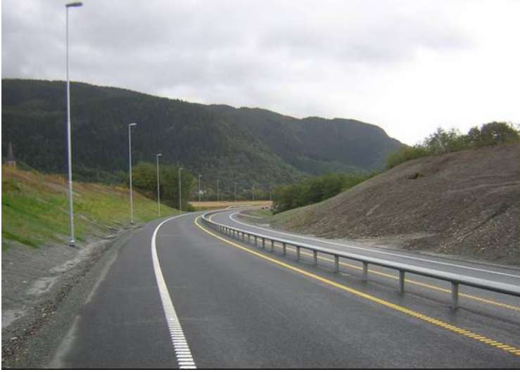
Şekil 5.7. Beton agregası kullanılan otoyolun yeni hali (Aurstad vd., 2006)
