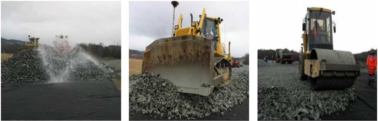
Şekil 5.6. Beton agregasının serilmesi ve sıkıştırılması (Aurstad vd., 2006)
