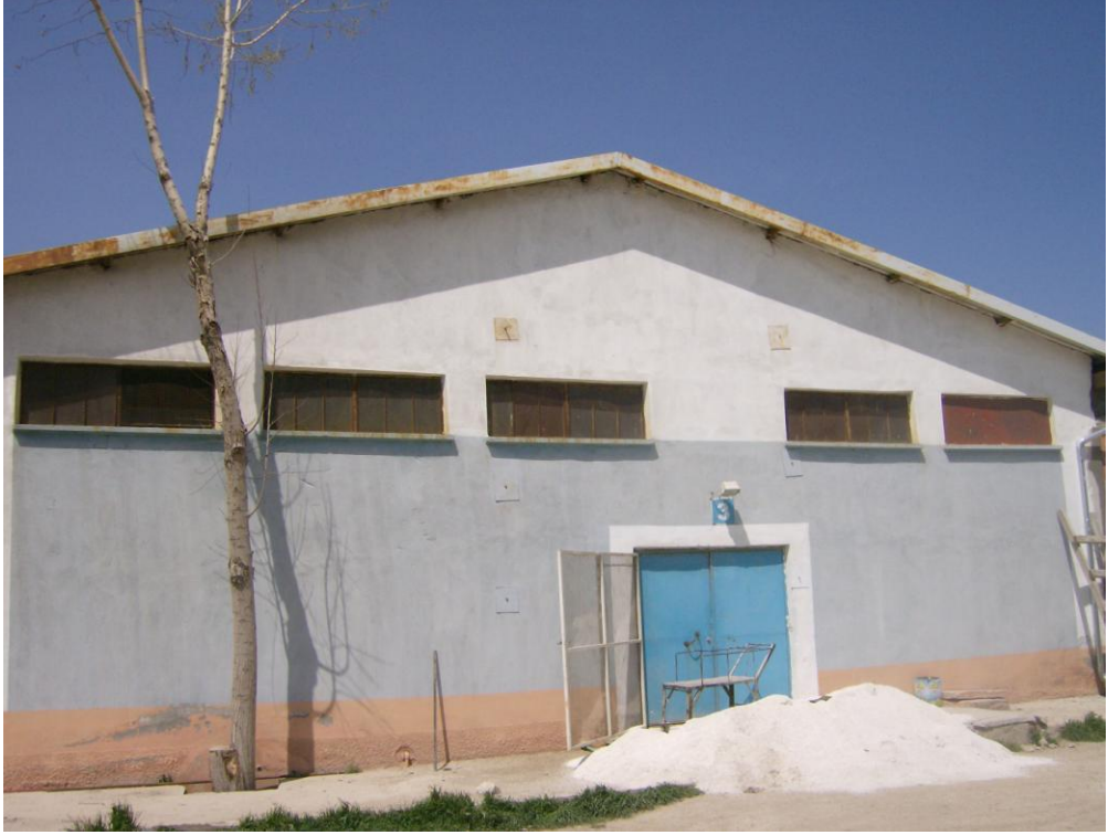
Şekil 4.3. 1 numaralı araştırma kümesinin giriş kapısının genel görünümü
