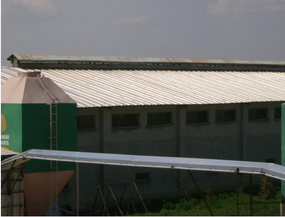
Şekil 4.6. Fener tipi havalandırma bacasının genel görünümü (1 numaralı kümes)
