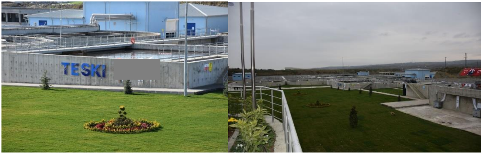
Şekil 3.1. Arıtma tesisi genel görünüm
