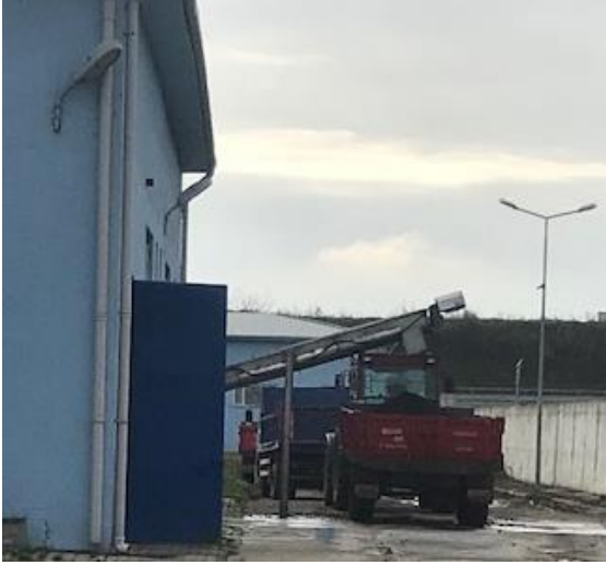
Şekil 3.4. Atık su arıtma tesisi çamur römork sistemi
